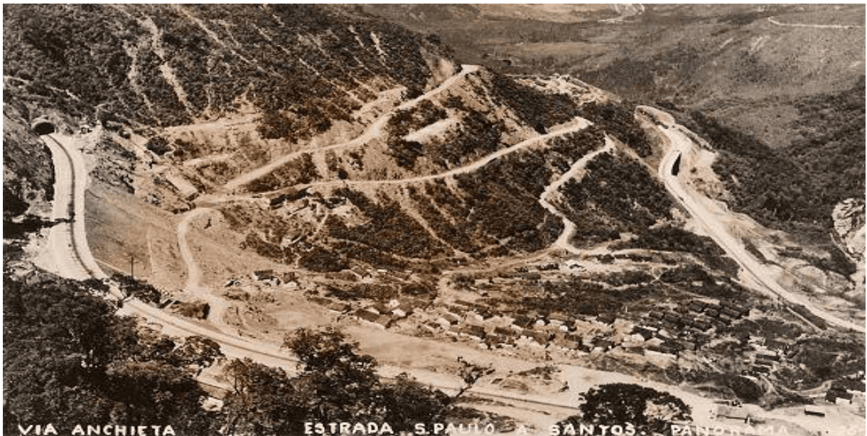
IMAGEM 15 - Construção da Via Anchieta
