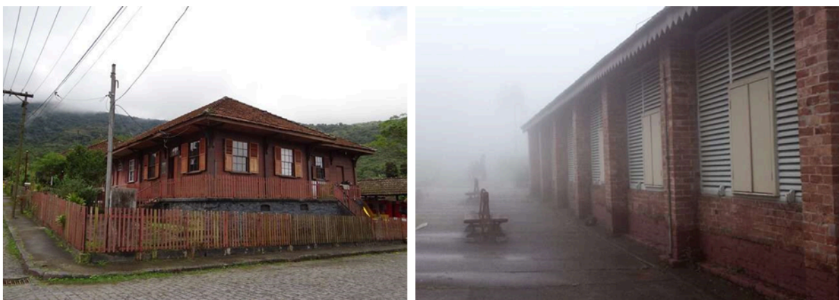
IMAGEM 14 - Padrão arquitetônico da vila nova em Paranapiacaba
