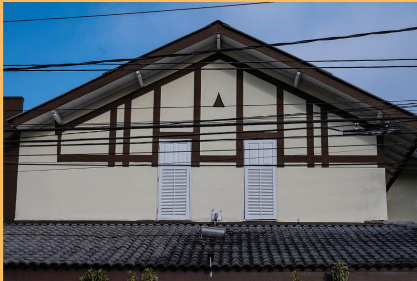
*Detalhe do andar superior da fachada lateral. Destaca-se a janela de uma folha em veneziana de madeira e a decoração que se valeu do enxaimel – técnica construtiva que originalmente valia-se do uso de hastes em madeira encaixadas entre si e preenchimento em alvenaria de tijolos ou pedras. Neste caso, trata-se de uma releitura decorativa feita em argamassa. Foto Beto Garavello, julho de 2022. Coleção CTAPC.*
