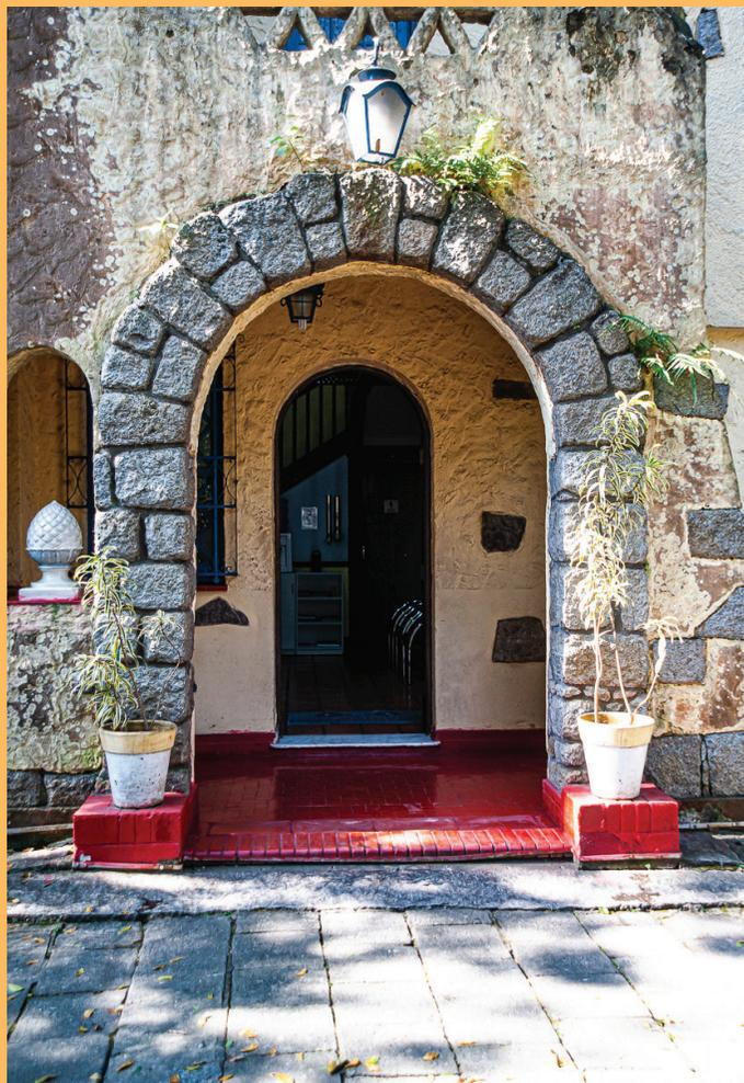
Detalhe da fachada principal da edificação com destaque para a porta em arco, notar o uso de reboco com superfície irregular e de pedras decorativas incrustadas na parede; luminárias em ferro com formato de lampião e no nicho à esquerda, a presença de pinha decorativa em louça. Todos esses elementos são característicos do Neocolonial hispano americano. Foto: David Rego Jr., julho de 2022. Coleção CTAPC.
