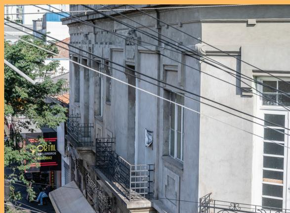
*Vista da parte superior da fachada da edificação. Nos balcões vê-se guarda corpos em ferro trabalhado e elementos decorativos que emolduram as esquadrias, destacando-se festões de flores sobre o vão das duas portas. Foto Beto Garavello, julho de 2022. Coleção CTAPC.*
