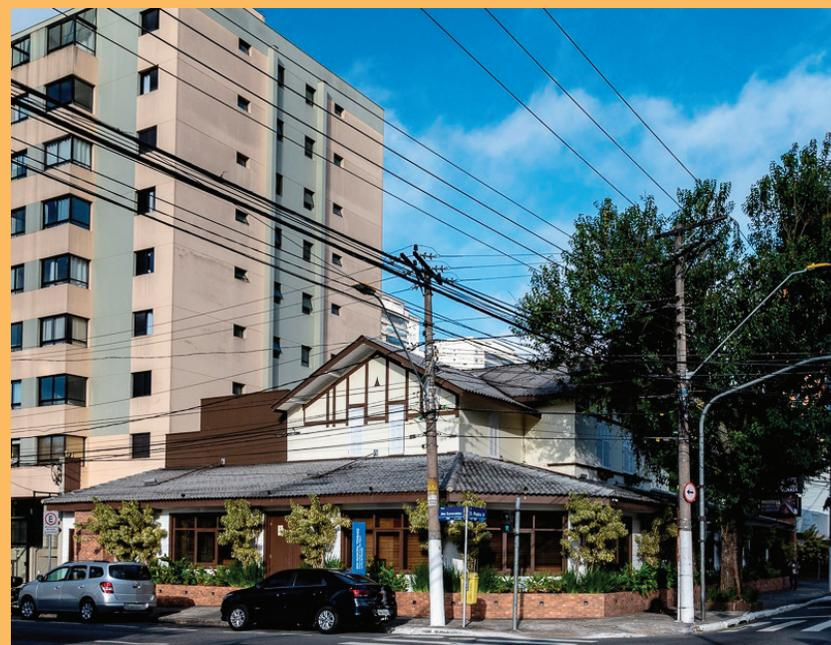
*Vista das fachadas lateral e principal deste sobrado construído na esquina. Destaca-se a parte superior da edificação que ainda contém elementos originais desde a construção nos anos 1920. São eles: a releitura da técnica enxaimel, as janelas com venezianas em madeira, o formato do telhado recortado e três triângulos em baixo relevo. O avanço no térreo foi construído em época mais recente para acomodar as atividades atuais. Foto Beto Garavello, julho de 2022. Coleção CTAPC.*
