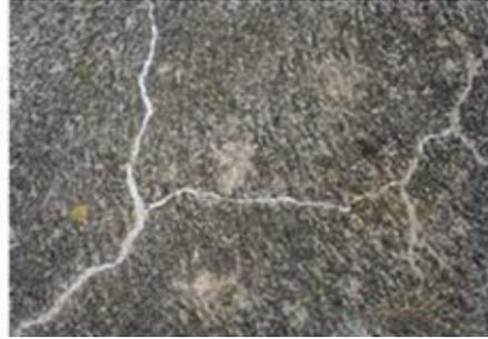
Detalhe da fissura preenchida com material branco<sup>1</sup>.
