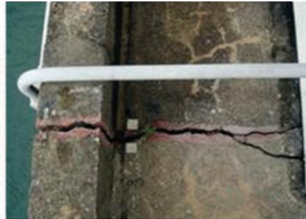
Fissuras na mesma barragem atingindo 10 mm.
