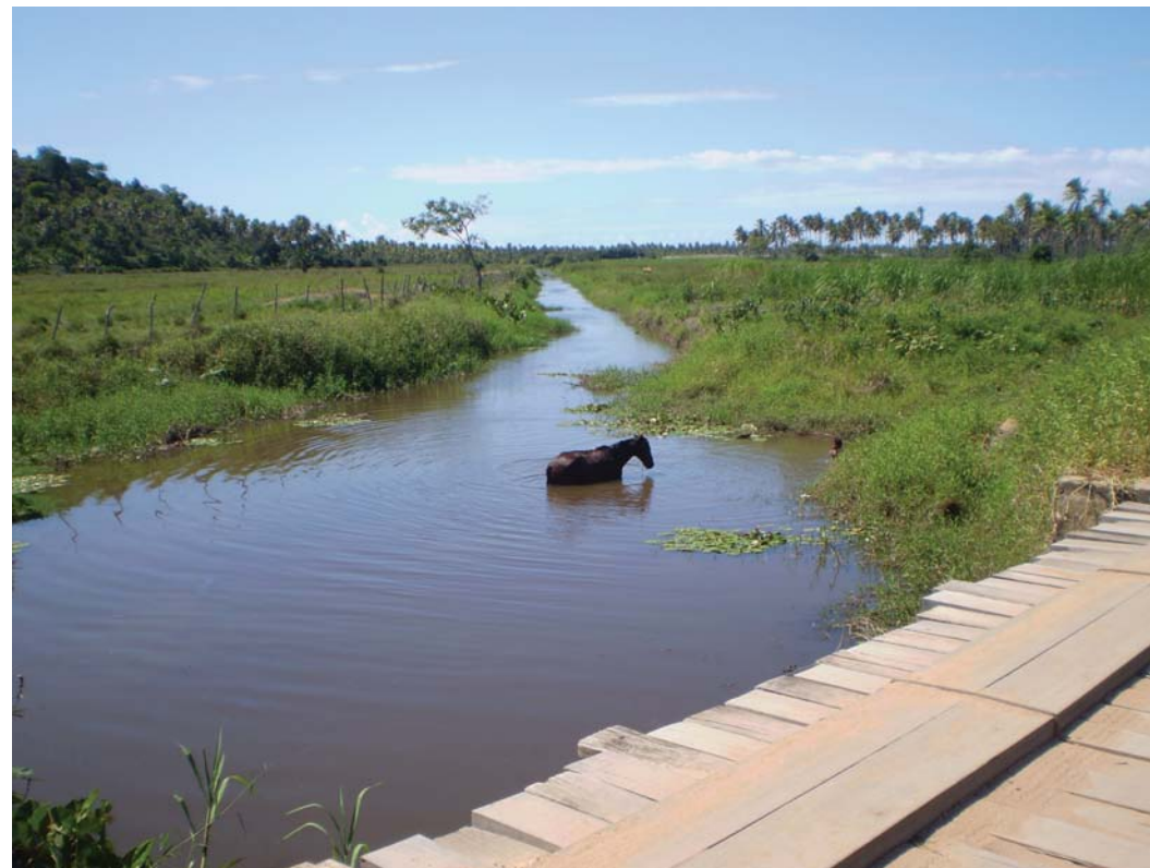
Rio Tabaiana, retificado - Maragogi, AL FOTO Banco de Imagens Engecorps
