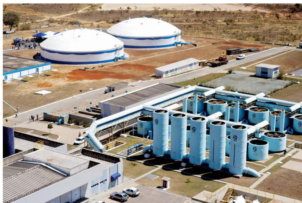
ETA Pipiripau - Brasília, DF FOTO Mary Leal | Banco de Imagens Caesb
