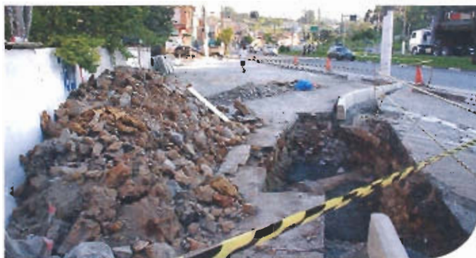
Estrutura metálica e rampas de concreto facilitarão acesso
