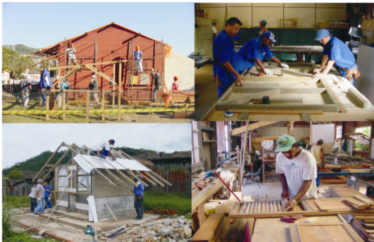
Imagem 8. Cooperativa de Marcenaria, Oficina do Banco de Materiais e Restauro das Casas Tipo E-CDARQ. Fonte: Pesquisa FAPESP/Fundação Santo André "Diretrizes e Procedimentos para a Recuperação do Patrimônio Habitacional em Madeira de Paranapiacaba". Fotos: Gilson Lameira.
