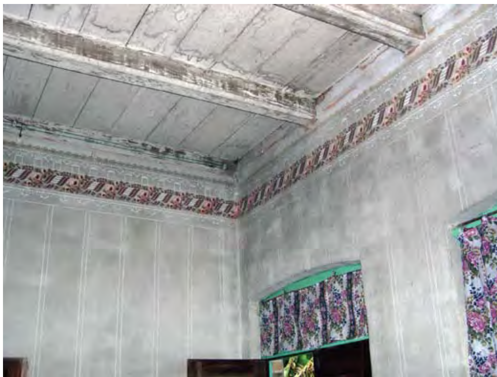
Fig. 4.12 – Pinturas à base de cal sobre rebocos de terra e cal e estruturas de madeira. Arquitetura da imigração, SC.
