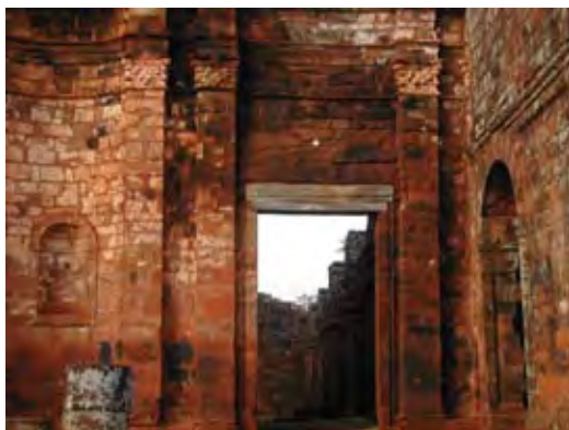
Fig. 1.22 – Degradação química das pedras acelerada por umidade, plantas e compostos orgânicos. São Miguel das Missões e São João, RS.
