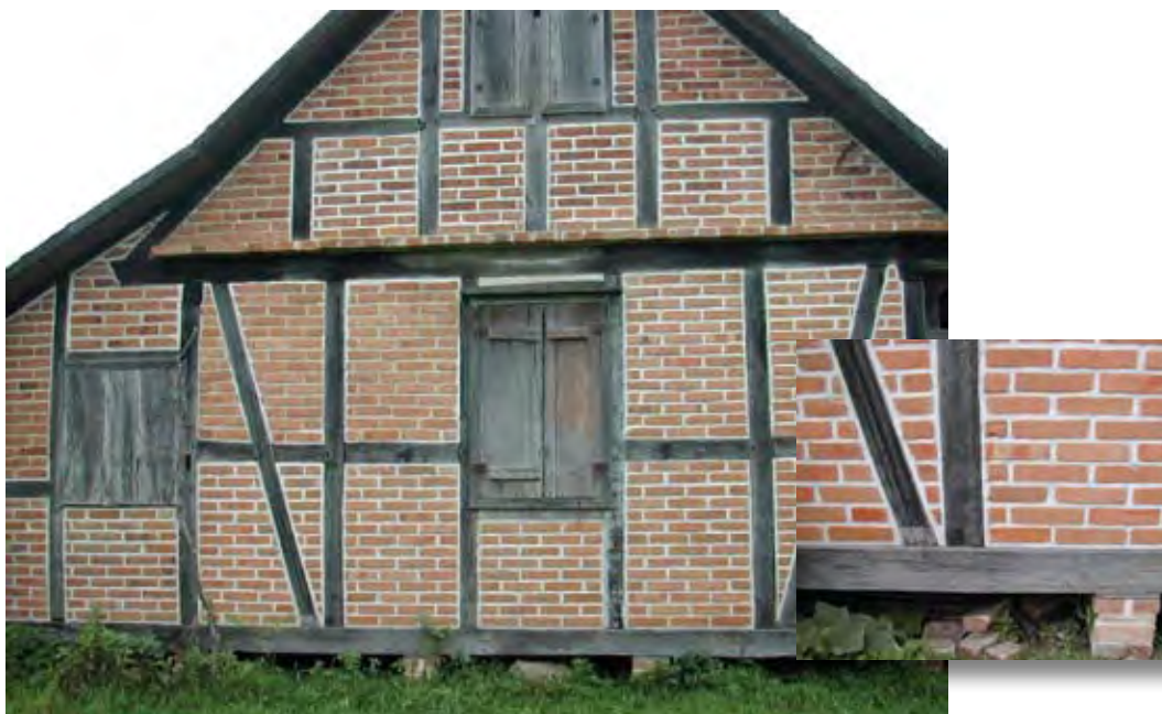
Fig. 1.16 – Intervenções de reparação dos rejuntas à base de cal em casas enxaimel, Pomerode, SC.
