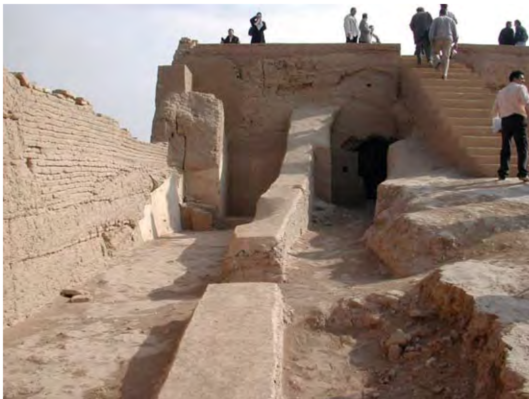
Fig. 3.19 – Capeamento das ruínas do castelo de Narin, Meybod, Irã.
