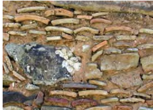
Fig.1.7 – Antigos muros com vestígios das argamassas de cal de conchas. Santo Antonio de Lisboa, Ilha de SC.
