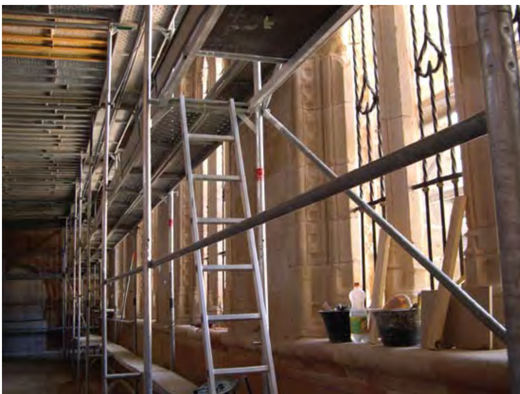
Fig. 1.14 – Intervenções de reparação em rendilhado de pedra, com argamassa e pó de pedra. Catedral de Sigüenza, Espanha.
