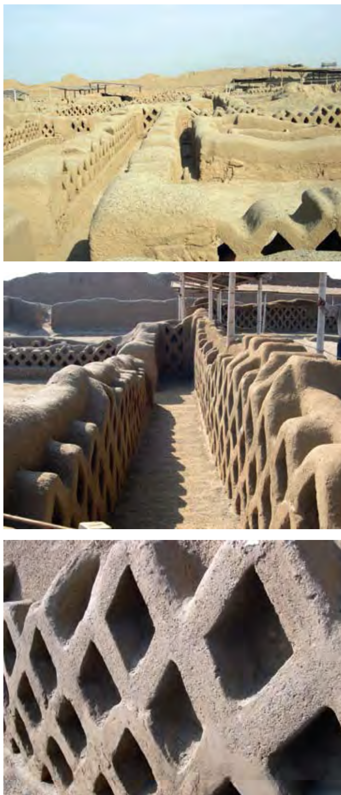
Fig. 3.18 – Capeamento das ruínas de Chan-Chan com argamassas de terra estabilizadas com cal. Peru.
