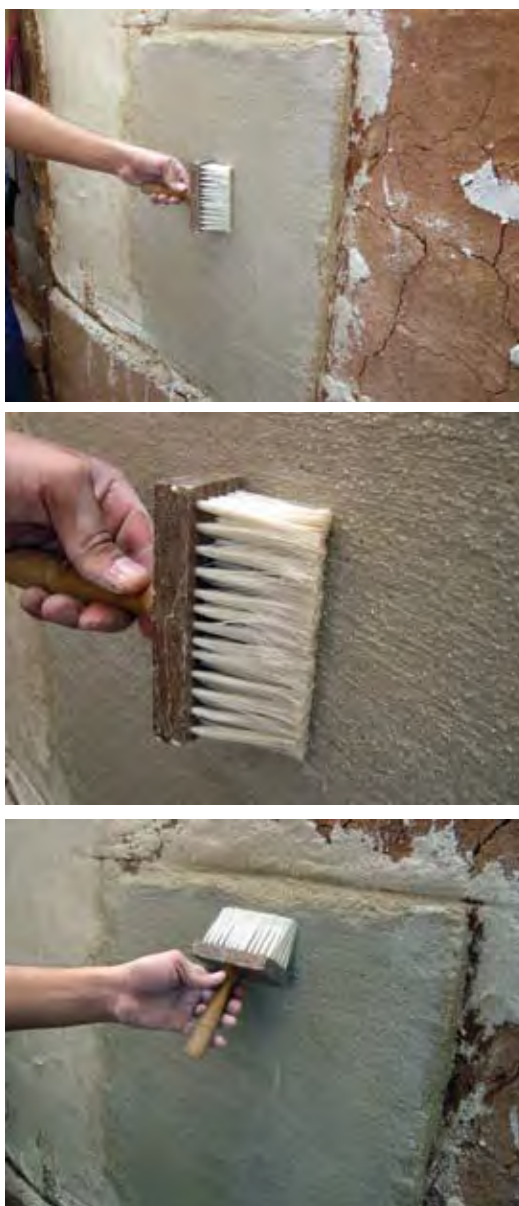
Fig. 4.16 – Técnicas de aplicação da caiação. Oficina de argamassas de cal, Escola de Arquitetura, UFMG.
