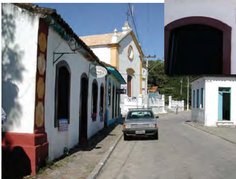
Fig. 4.3 – Pintura tradicional simulando elementos decorativos. Manutenção feita sem usar a caiçação tradicional. Santo Antonio de Lisboa, Ilha de SC.
