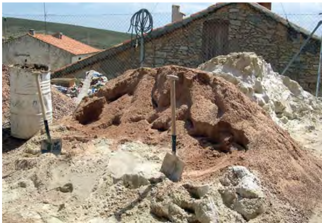
Fig. 3.13 – Reintegrações de reforço temporárias. Castelo de Embid, Espanha.
