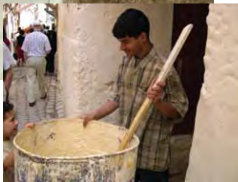
Fig. 4.7 – Conservação das alvenarias em Fez com a tradicional caiação, Marrocos.
