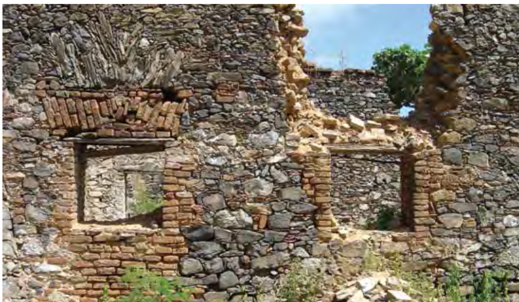
Fig.1.9 – Sistemas de argamassas e juntas em alvenarias de pedra. Fortes em Fernando de Noronha, Forte Orange, PE, Ruínas de São Lourenço, RS.
