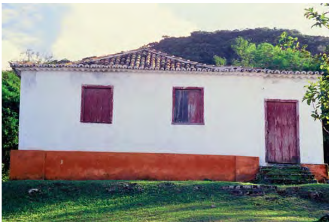
Fig. 4.5 – Recuperações com cal. Casa do Vigário, Lagoa da Conceição, Ilha de SC.
