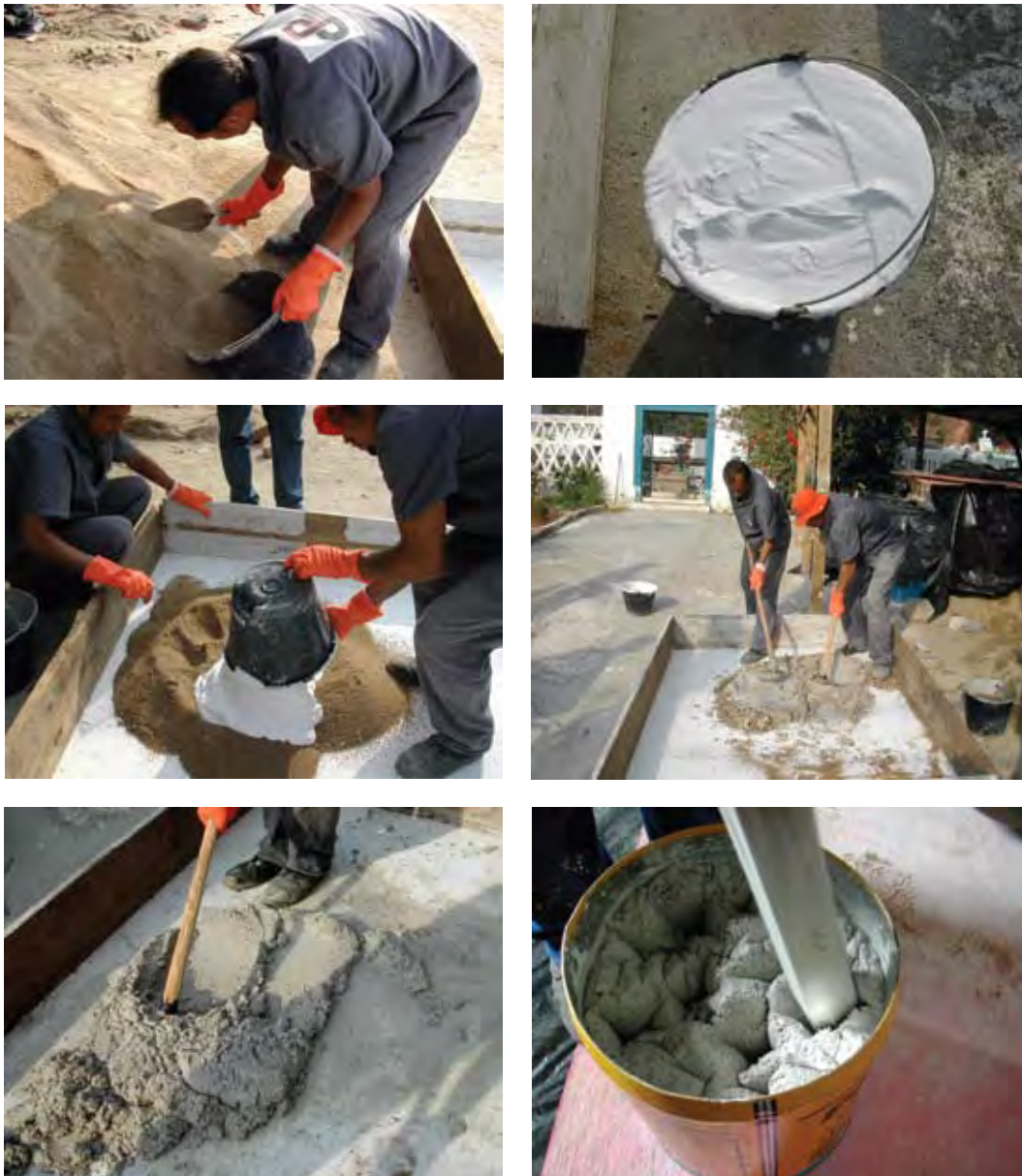
Fig. 3.10 – Preparação de argamassas manualmente. Ig. N.S. Necessidades, Florianópolis, SC e Ig. N.S. Corrente, Penedo, AL.
