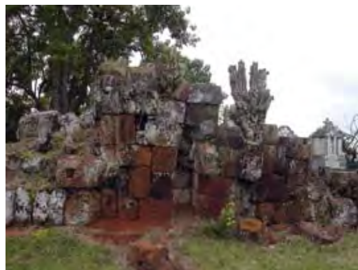
Fig. 1.22 – Degradação química das pedras acelerada por umidade, plantas e compostos orgânicos. São Miguel das Missões e São João, RS.
