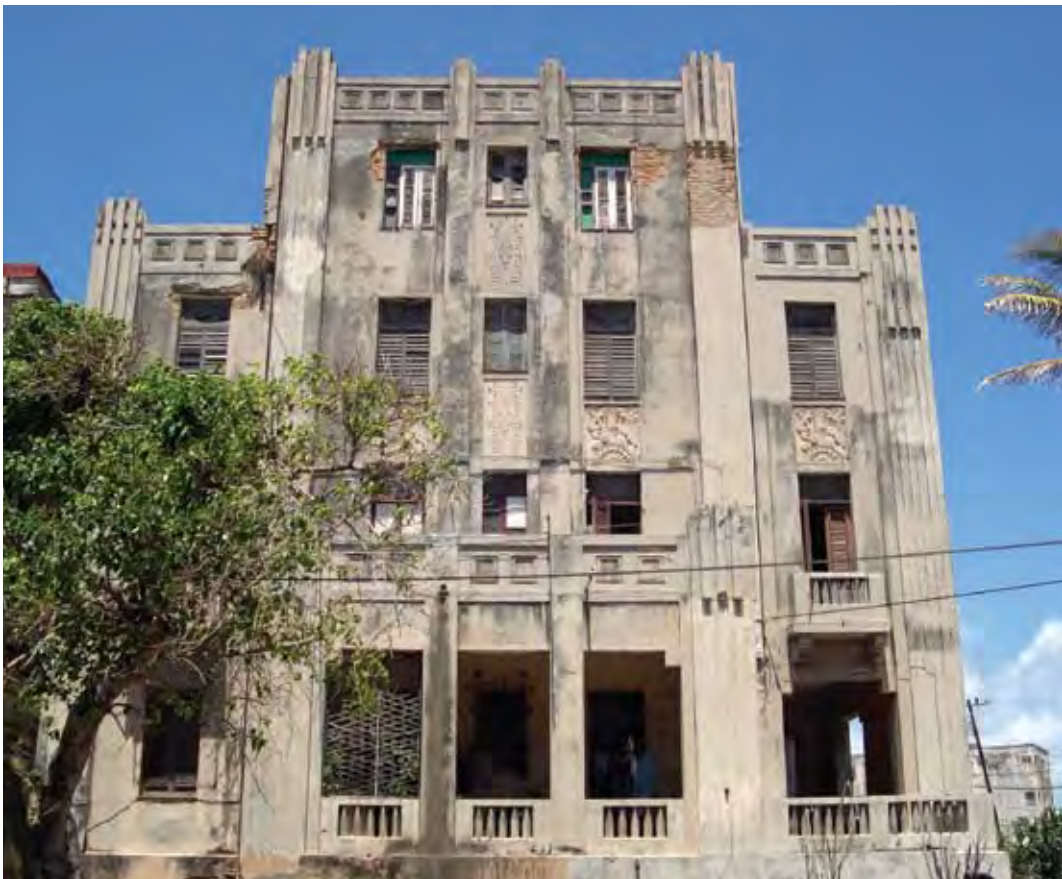
Fig. 4.21 – Revestimentos e ornatos decorativos do final do séc. XIX e início do séc. XX contendo agregados e pigmentos variados. Havana, bairro do Vedado, Cuba.
