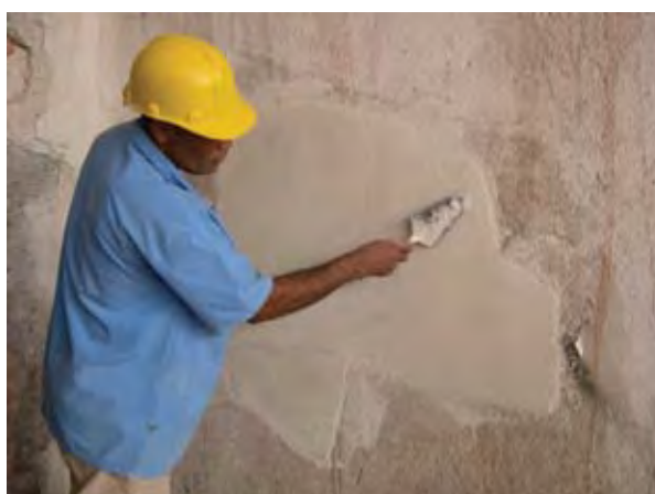
Fig. 3.20 – Demonstrações de argamassas ricas em cal para acabamento. Aula prática, CECRE, Oficina Escola, Salvador.
