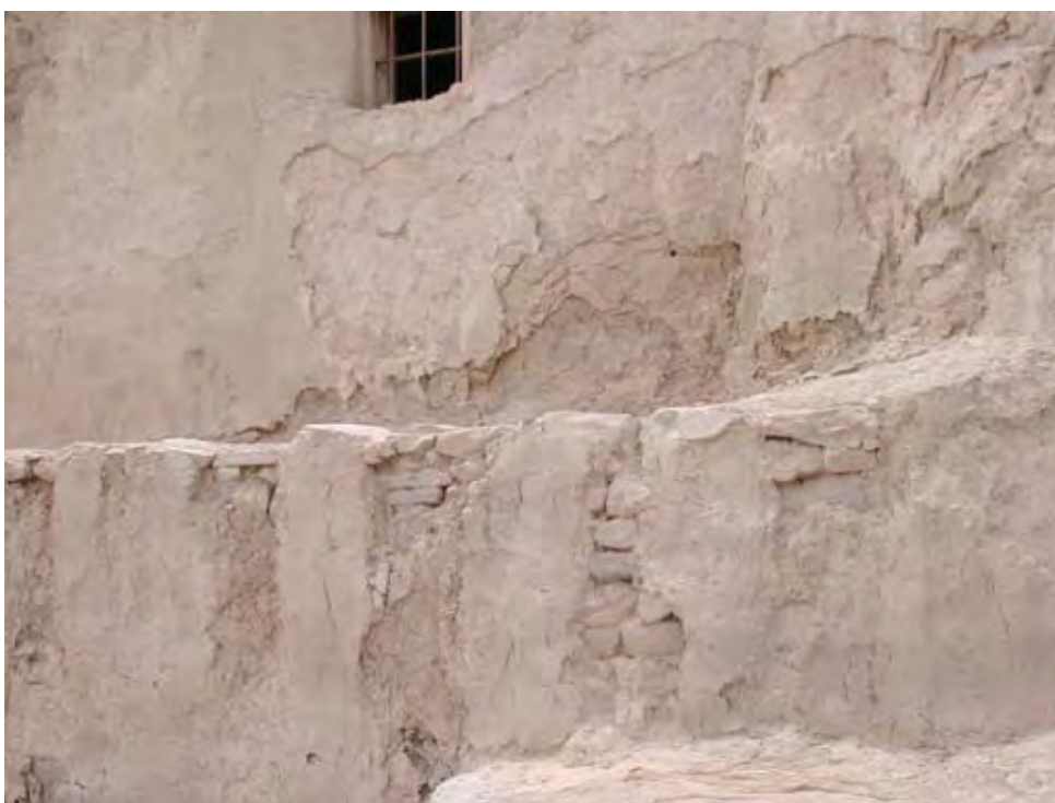
Fig. 3.8 – Fibras nas argamassas dos rebocos de terra e cal. Acoma City, EUA.
