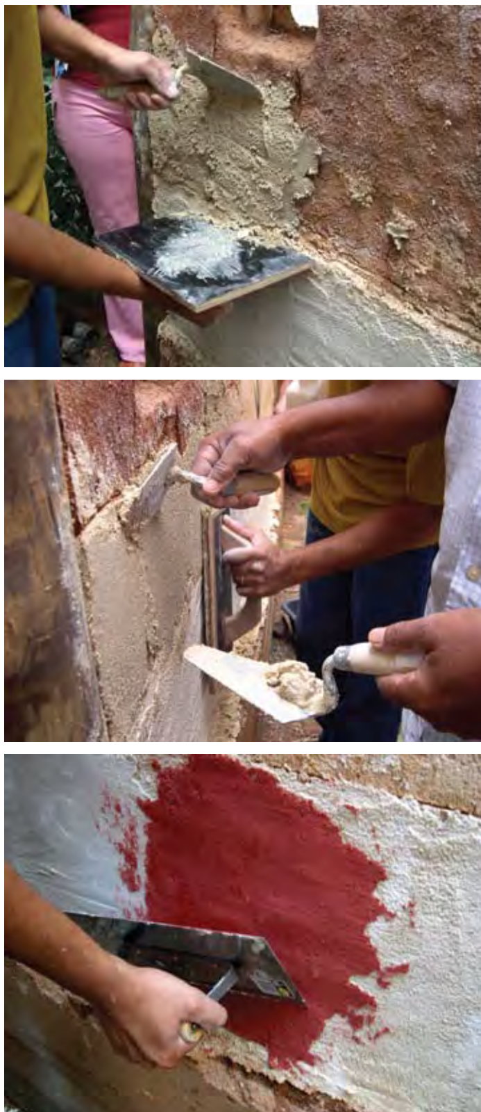
Fig. 4.20 – Treinamento prático com argamassas pigmentadas com mestres mineiros durante oficina de argamassas de cal da escola de arquitetura da UFMG.
