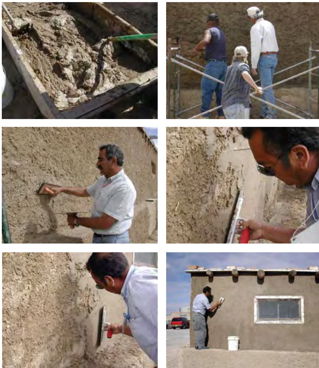
Fig. 3.23 – Aplicação de emboço e acabamento. Acoma City, EUA.
