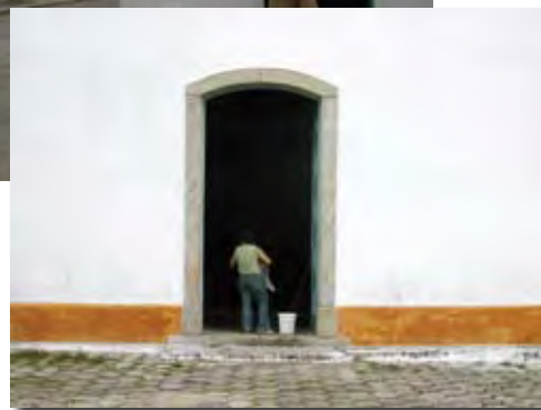
Fig. 4.8 – Recuperação da pintura das alvenarias e dos ornatos com a caiação. Ig. N.S. Necessidades, SC.
