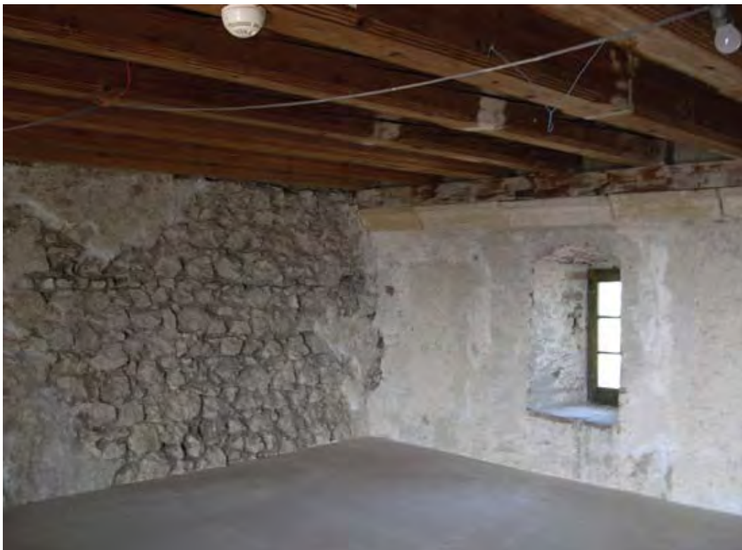
Fig. 3.21 – Recuperação dos interiores do Castelo de Aarburg Festung com diversas tipologias de argamassas de acabamento à base de cal e tintas. Suíça.
