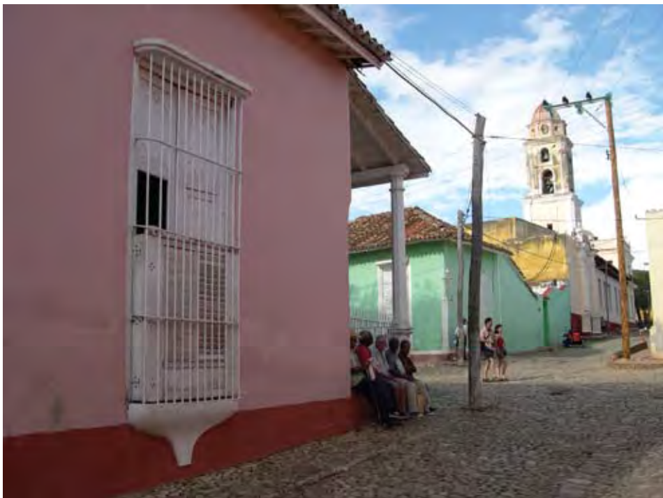
Fig. 4.6 – Recuperação arquitetônica usando a tradicional caiação e critérios técnicos na escolha da cor. Trinidad, Cuba.
