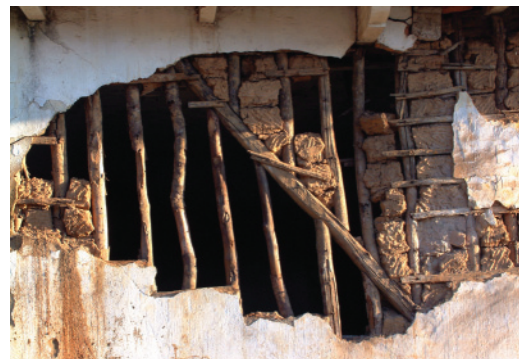
Figura 3.3 - Detalhe de parede de pau-a-pique.
