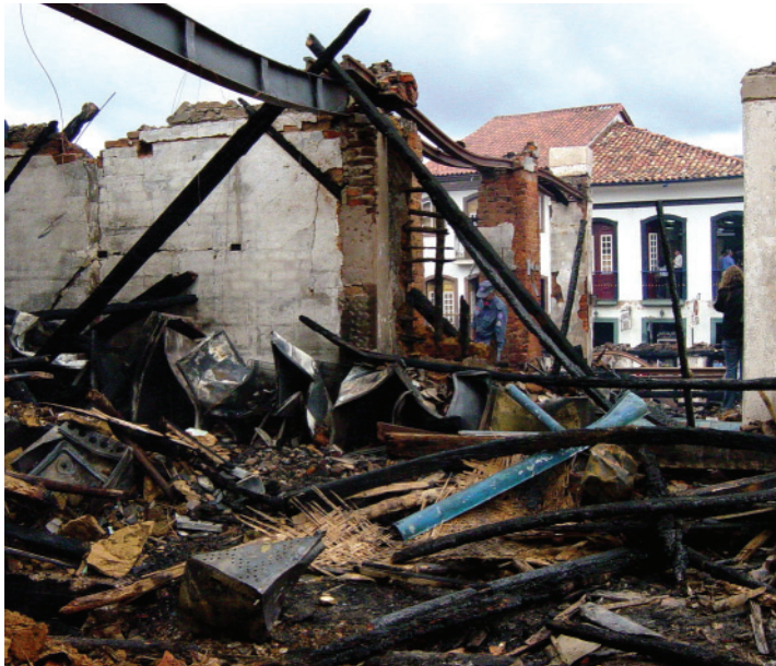
Figura 1.4 – Incêndio do Hotel Pilão em Ouro Preto: severidade alta.
