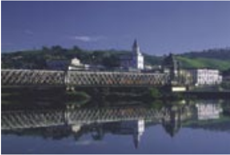
Ponte D. Pedro II sobre o Rio Paraguaçu
