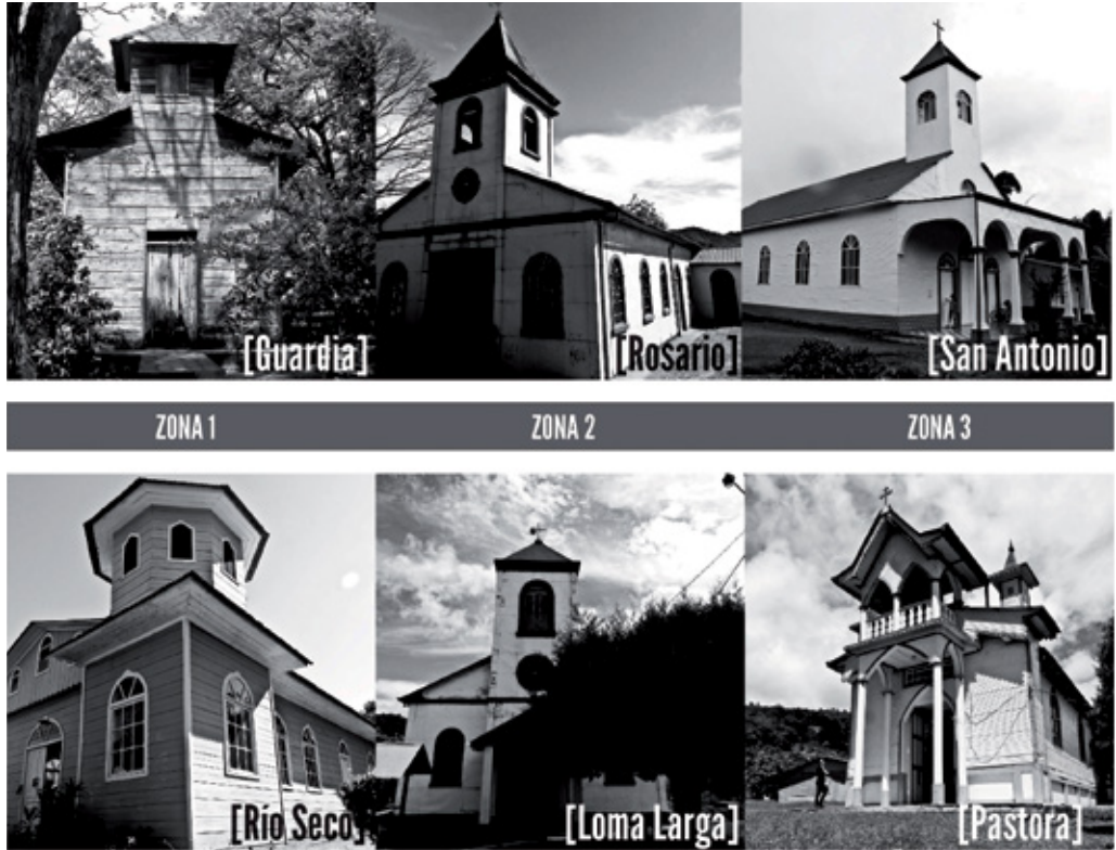
Figura 4 Imágenes de las 6 edificaciones de estudio
