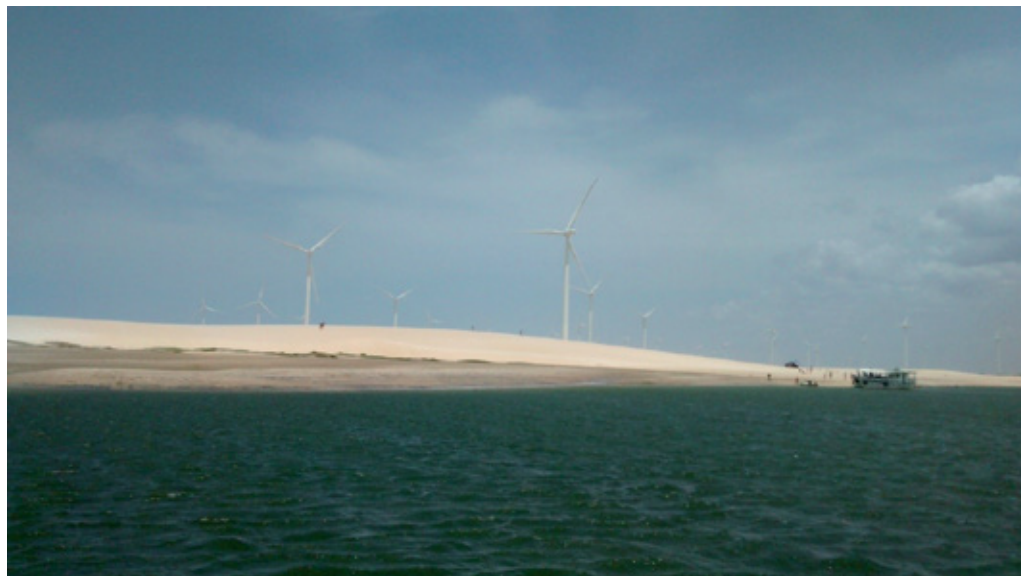
Figura 4 Torres de captação de energia eólica no litoral do Rio Grande do Norte, Brasil, em fevereiro de 2015
