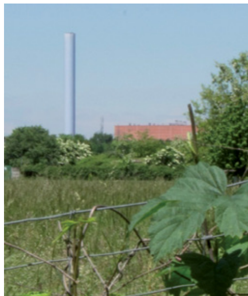
Figura 2 Container da turbina-gerador de uma usina hidrelétrica enterrado nos Alpes italianos
