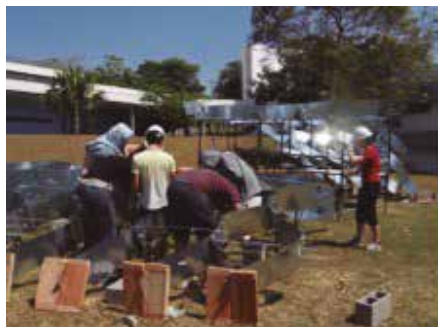
Figura 10: Canteiro de montagem. Fonte: Nomads.usp.
