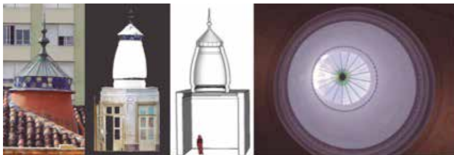
Figura 09: Na sequência, fotografia da cobertura da claraboia da Casa do Conselheiro, projeção ortogonal da nuvem de pontos do escaneamento 3D, seção perspectivada de todo o elemento e fotografia do ponto de vista inferior à claraboia. Fonte: acervo GEGRADI/FAURB/UFPel. O modelo digital foi produzido pela acadêmica de arquitetura Gabriela Peronti, 2015
