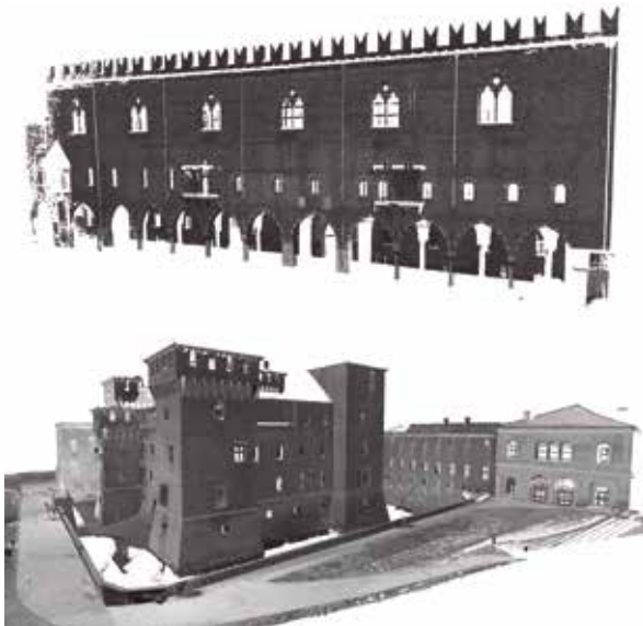
Figura 6: Viste della nuvola di punti ottenuta con tecnologia laser scanning. In alto il Palazzo del Capitano, in basso il Castello di San Giorgio
