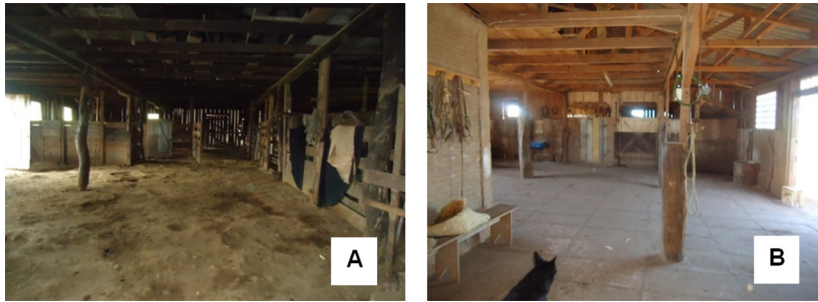
Figura 15 – Galpão de chão batido Galpão pavimentado
