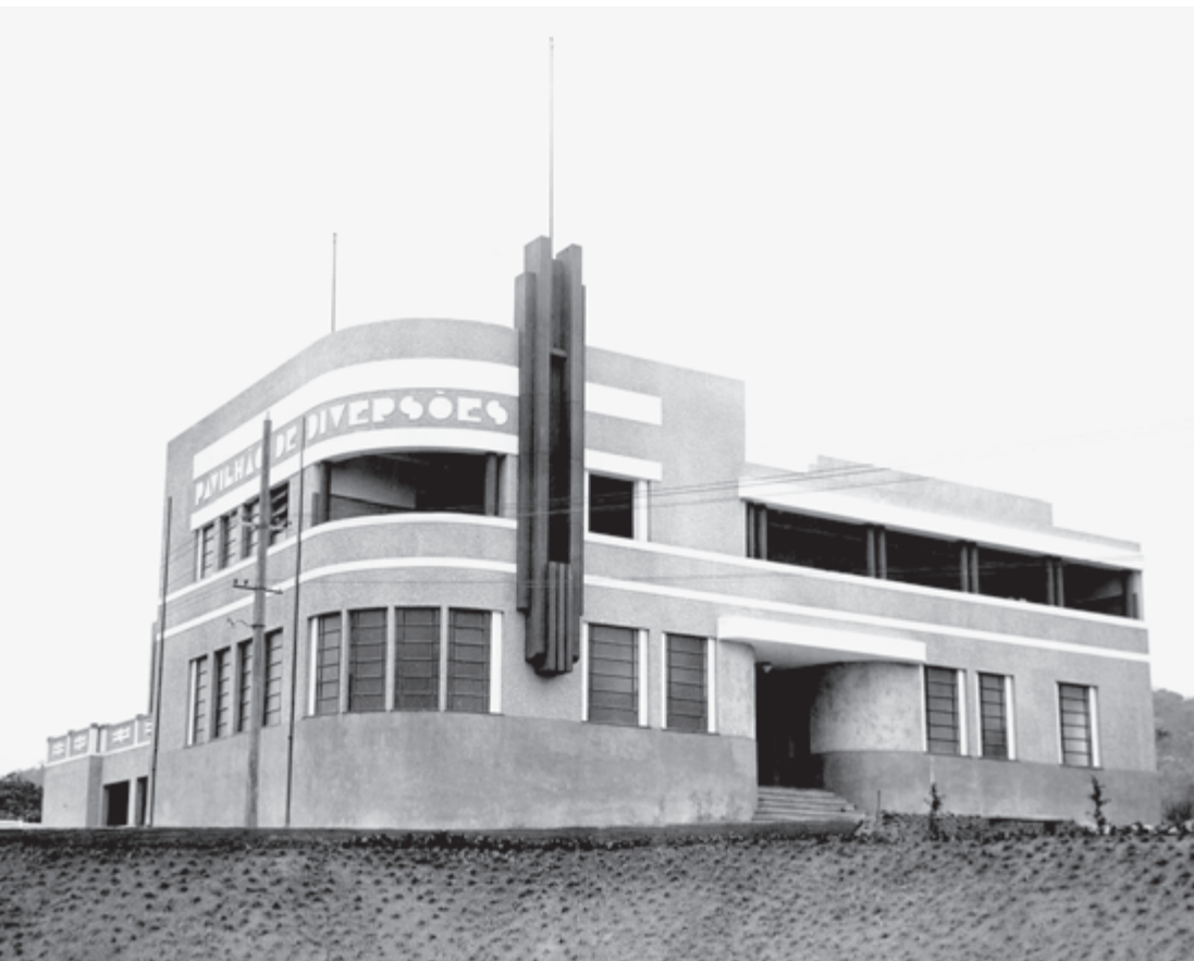
Pavilhão de Diversões , Colônia de Curupaity, [s.d.]. Acervo Cpdoc/FGV Vista do Pavilhão de Diversões da Colônia de Curupaity, exemplar da arquitetura art déco , que neste espaço de entretenimento adota linguagem arquitetônica diferenciada em relação à dos demais edifícios propostos para o hospital-colônia.
