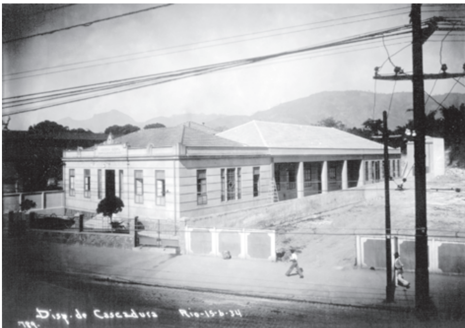
Dispensário de Cascadura, 1934. Foto Augusto Malta. Acervo Arquivo Geral da Cidade do Rio de Janeiro
