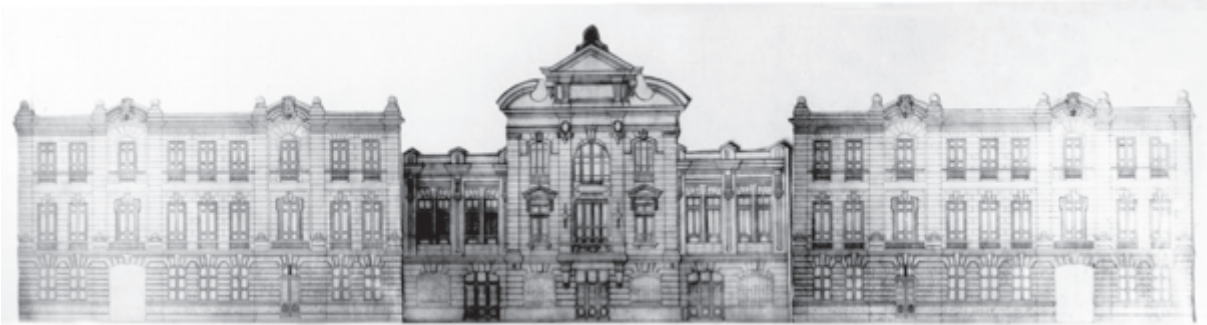
Posto Central de Assistência , [s.d.]. Acervo Arquivo Geral da Cidade do Rio de Janeiro
