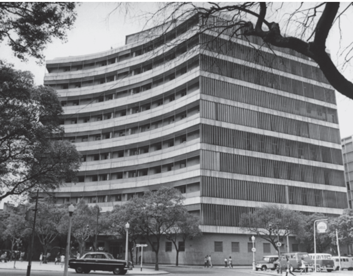
Fachada do INCa na praça da Cruz Vermelha, [s.d.]. Acervo Arquivo Nacional, Fundo Correio da Manhã Em 1957 é inaugurada a nova sede do Instituto Nacional de Câncer, na praça da Cruz Vermelha, onde se localiza até hoje. O edifício é um dos exemplares da moderna arquitetura hospitalar praticada nos anos 1950. A praça foi construída em 1907.
