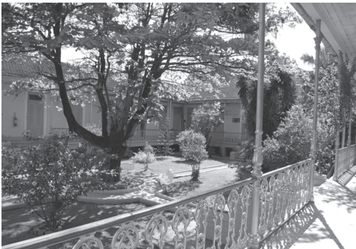
Hospital Evangélico , 2008. Foto Roberto Jesus Oscar e Vinícius Pequeno. Acervo Casa de Oswaldo Cruz Vista do pátio interno do Hospital Evangélico, criado para facilitar a aeração e a ventilação dos quartos, proposta clara da tipologia dos hospitais higienistas.
