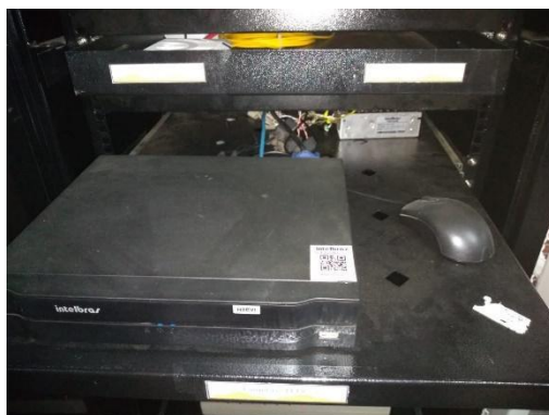
Figura 07 - Central de monitoramento
