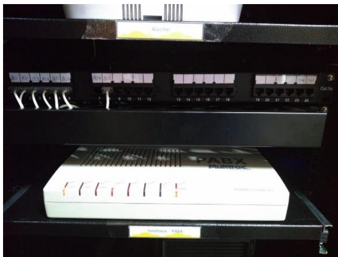
Figura 06 - PABX Multitoc 208 instalado na Tonetto.
