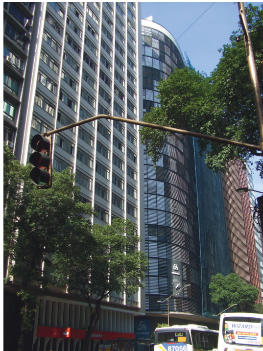
Figura 74 e 75. Prédios da Avenida Rio Branco
