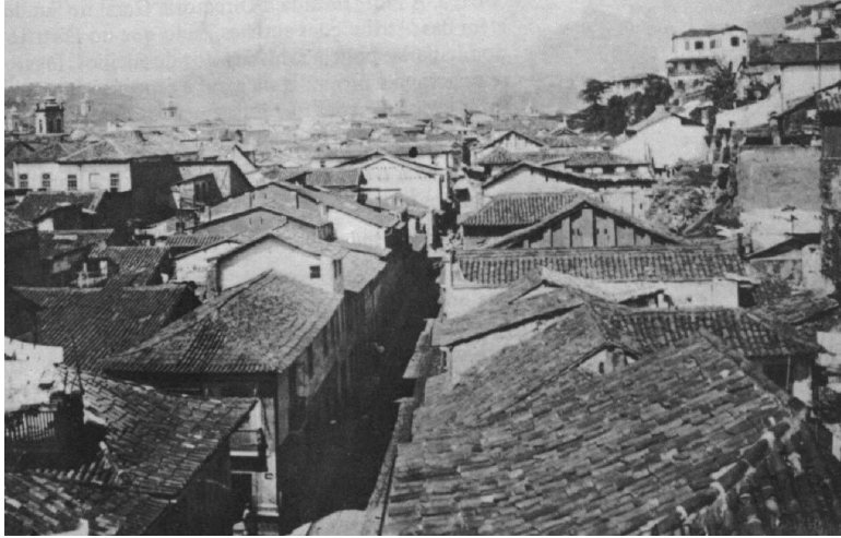
11. Rua da Prinha antes da reforma - foto de Augusto Malta - 1903
