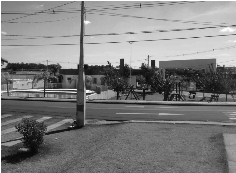
Figura 16 – Vista parcial das piscinas e playground do Condomínio Terra Nova São Carlos, São Carlos
