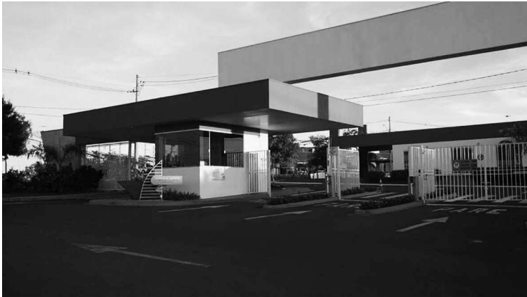
Figura 15 – Portaria do Condomínio Terra Nova São Carlos, São Carlos
