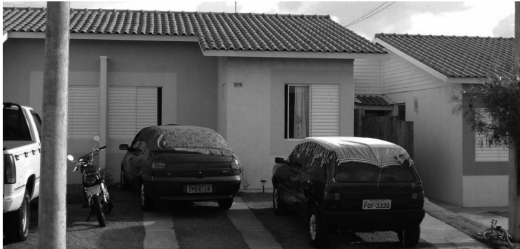
Figura 23 – Delimitação com cercas de bambu entre as residências do Condomínio Terra Nova São Carlos, São Carlos
