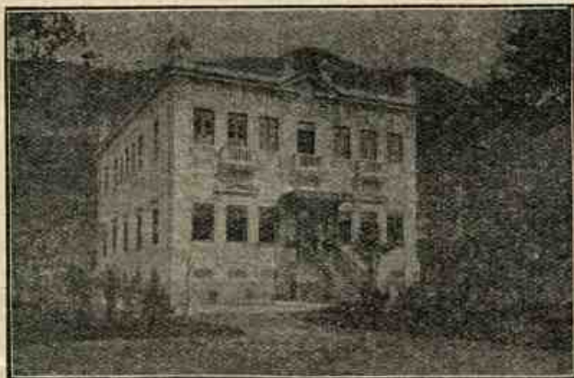
Edificio do Departamento Feminino, á rua Conde de Bomfim, 743
