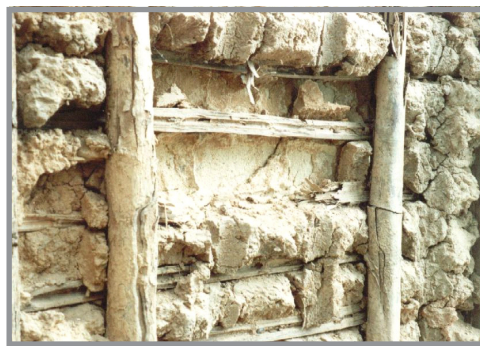
Figura 14: pau-a-pique (Cidade de Goiás, GO). Fonte: foto de Lourenço, L. A. B. (2001).
