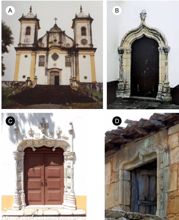
Figura 1: (A) Frontal da Igreja de São Francisco de Paula em estilo arco contracurvado (Ouro Preto-MG). Foto: Marcos Ferreira-Santos, 2008. (B) Portal em arco contracurvado (Sintra, Portugal). Foto: Rafael Baptista, 2017. (C) Portal em arco contracurvado manuelino, da Capela do Santo Espírito (Sintra, Portugal). Foto: Rafael Baptista, 2017. (D) Janela em arco contracurvado manuelino, do Conselho de Armamar (Viseu, Portugal). Foto: Manuel Ferros, 2016.
