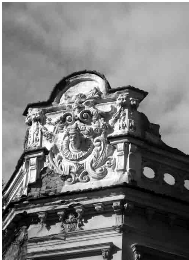
Figura 26 – Rua do Lavradio, esquina com Rua Relação, 300 (detalhe de ornamentação)
