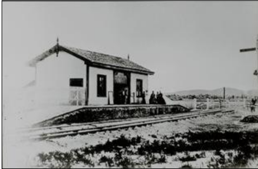
Figura 2- Estação Ferroviária de São Bernardo, atual Estação Prefeito Celso Daniel - Santo André, inaugurada em 16 de fevereiro de 1867. Hoje neste local está a passarela de pedestres. Coleção RFFSA. Acervo MSAOAG
