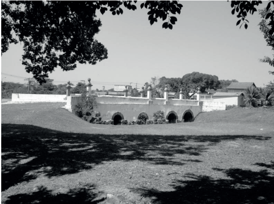
Foto 2. Ponte dos Jesuítas, Santa Cruz (RJ)
