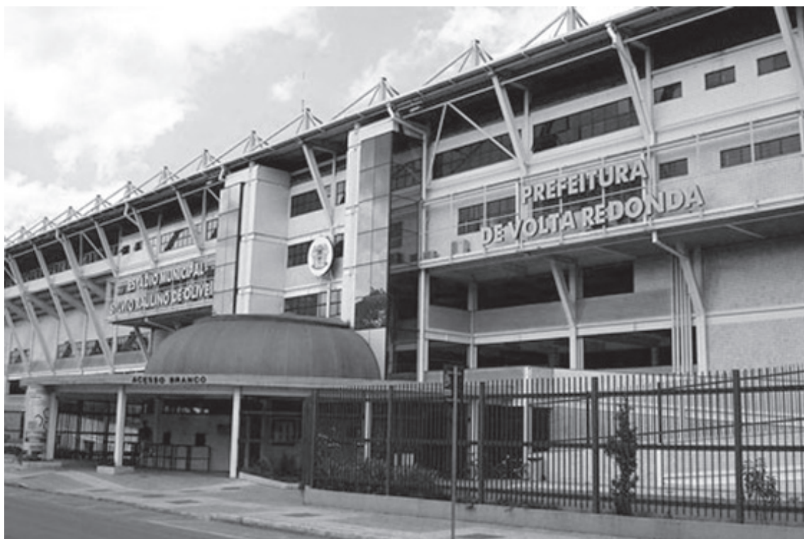
Figura 4. Foto da entrada principal do estádio municipal Sylvio Raulino de Oliveira
