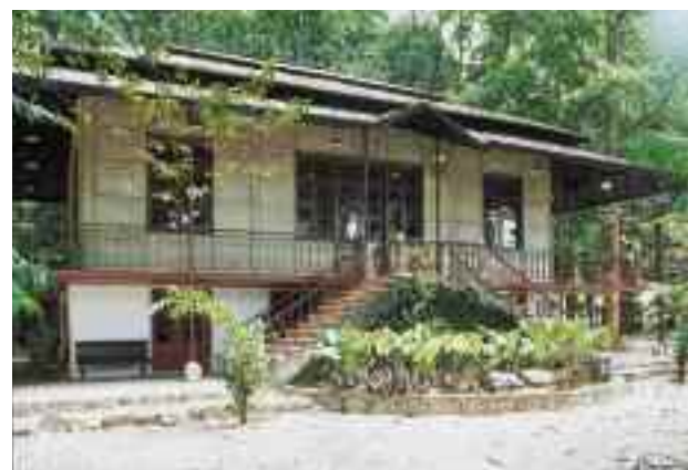
Abaixo. CASA DE FERRO PRÉ-FABRICADA, de 1893, desmontada e remontada no campus da Universidade Federal do Pará, Belém (PA).
