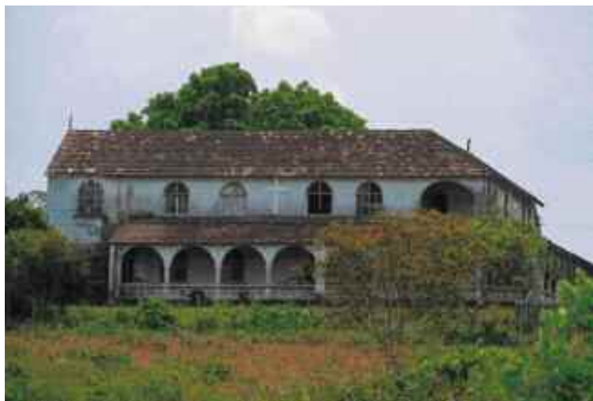
Acima. EDIFICAÇÃO remanescente da vila residencial Fordlândia, construída por Henry Ford para os trabalhadores do empreendimento de produção e exportação da borracha, em 1920, no município de Aveiro (PA).
