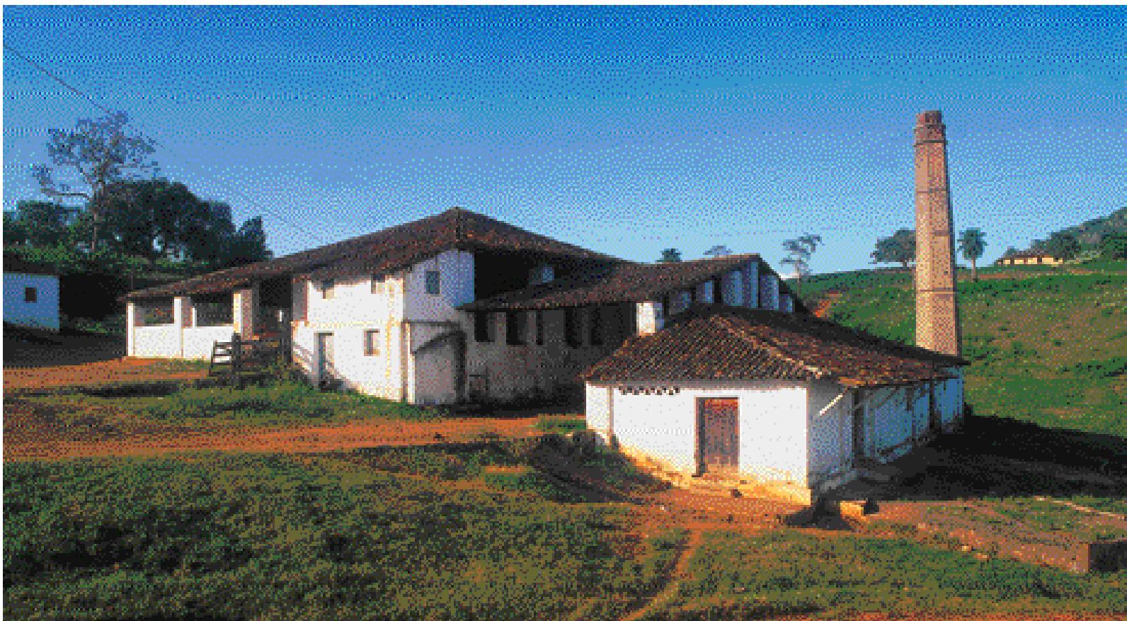
Abaixo. MOITA DO ENGENHO TRAPUÁ, Tracunhaém (PE). O edifício está assentado em terreno em declive para que o melado da cana siga o lay out industrial somente com a força da gravidade.
