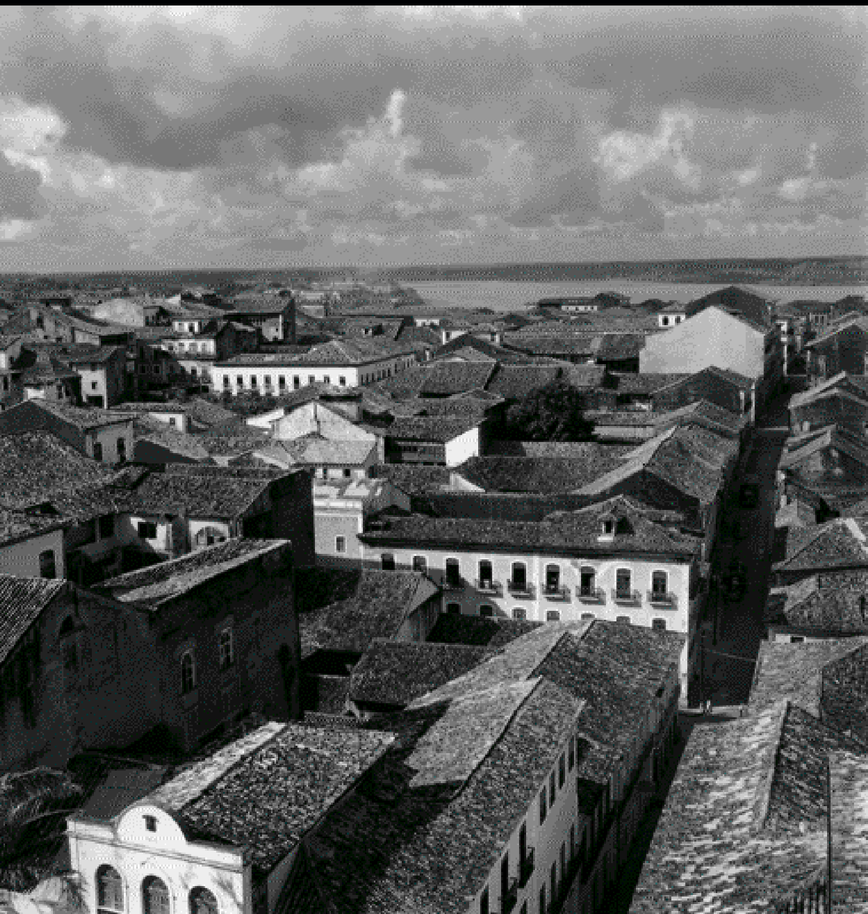
Acima. VISTA PARCIAL DOS TELHADOS em telha canal do centro histórico de São Luís, revelando a concentração de sólidas edificações, com reduzidas áreas livres, resultante do traçado geométrico de pequenas quadras.
