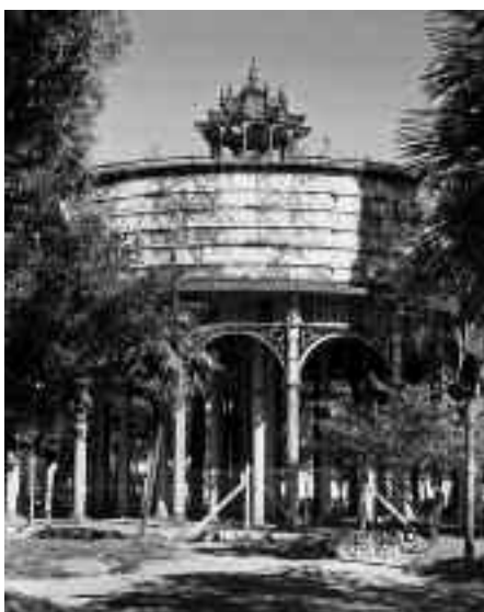
Abaixo. CAIXA D'ÁGUA EM FERRO FUNDIDO, Pelotas (RS). Estrutura metálica industrial, francesa, montada no local em 1875.
