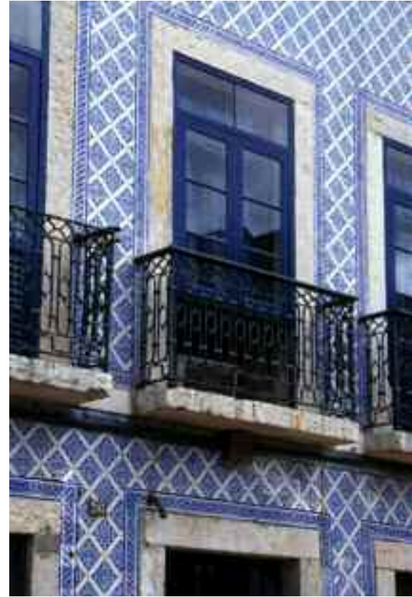
Acima. DETALHE DE FACHADA DE SOBRAÇÃO DA RUA PORTUGAL, São Luís (MA), revestida de azulejos portugueses do século XIX e que apresenta harmoniosa repetição de elementos construtivos em cantaria de lioz nas molduras de portas e janelas e também nas bacias dos balcões.
