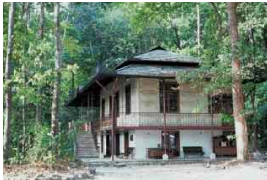
Acima e abaixo. CASA DE FERRO PRÉ-FABRICADA, de 1880, desmontada e remontada no Bosque Rodrigues Alves, Belém (PA).
