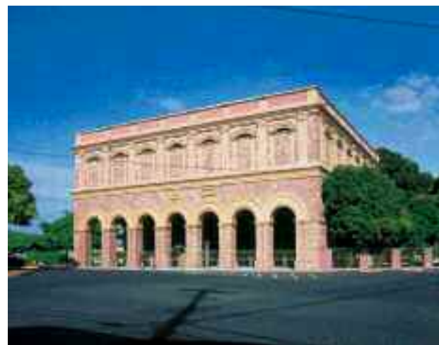
Acima. INTERESSANTE EXEMPLO de reservatório de água, envolvido com paredes de alvenaria de tijolos. Caixa d'água e estrutura de ferro pré-fabricada provenientes da Inglaterra.
