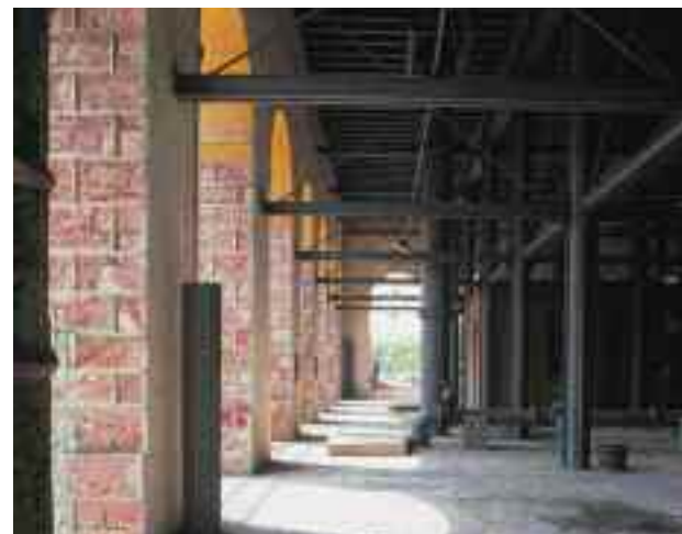
Abaixo. VISTA INTERIOR da referido reservatório de água.
