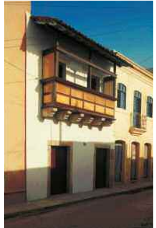
Acima. CASA COM BALCÃO em treliças de madeira e cachorros de pedra na rua do Amparo, Olinda (PE). Provavelmente este balcão era fechado, configurando, assim, um muxarabi de origem árabe.
