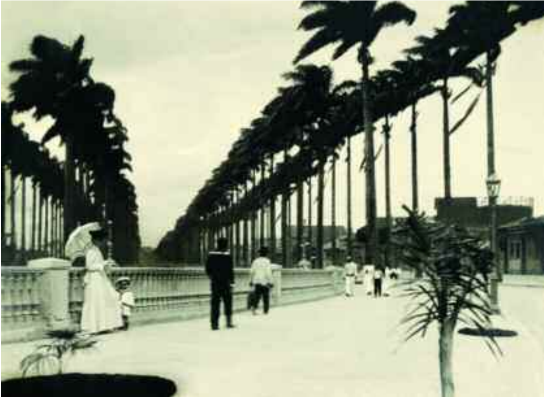
Ao lado. CANAL DO MANGUE , construído na segunda metade do século XIX, por iniciativa do visconde de Mauá, para a drenagem dos mangais de São Diogo. Atualmente, avenida Francisco Bicalho, Rio de Janeiro (RJ). Foto de 1907.
