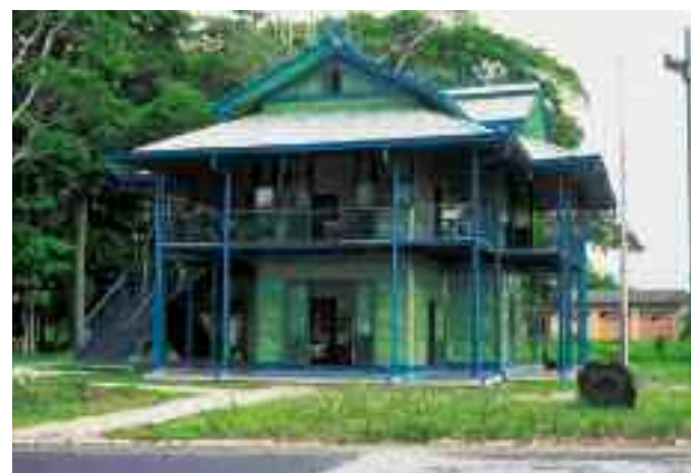
Abaixo. CASA DE FERRO PRÉ-FABRICADA, de 1893, desmontada e remontada no campus da Universidade Federal do Pará, Belém (PA).
