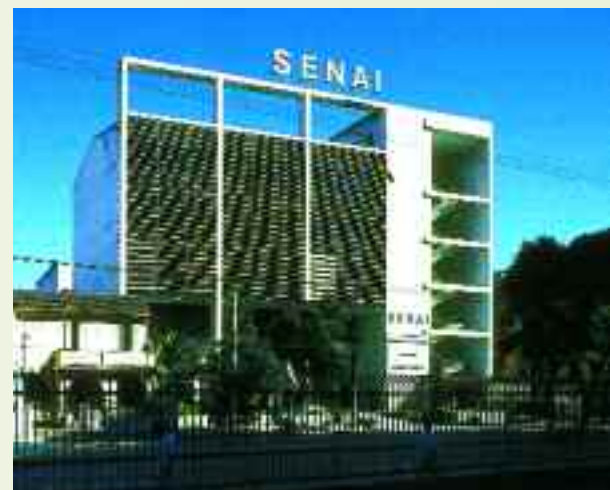
Acima. ESCOLA SENAI, Rio de Janeiro (RJ), de 1946, projetado por Marcelo e Milton Roberto. Exemplo de edifício de caráter moderno criado com a organização do ensino industrial no Brasil.
