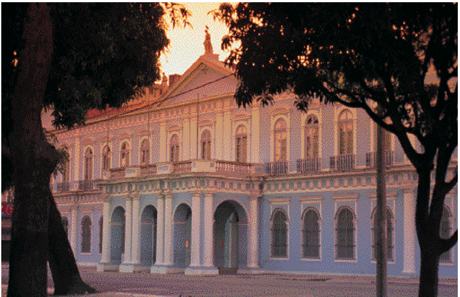
Abaixo. PALÁCIO ANTONIO LEMOS, inaugurado em 1893. Atual sede da Prefeitura e Museu do Estado do Pará, Belém (PA).
