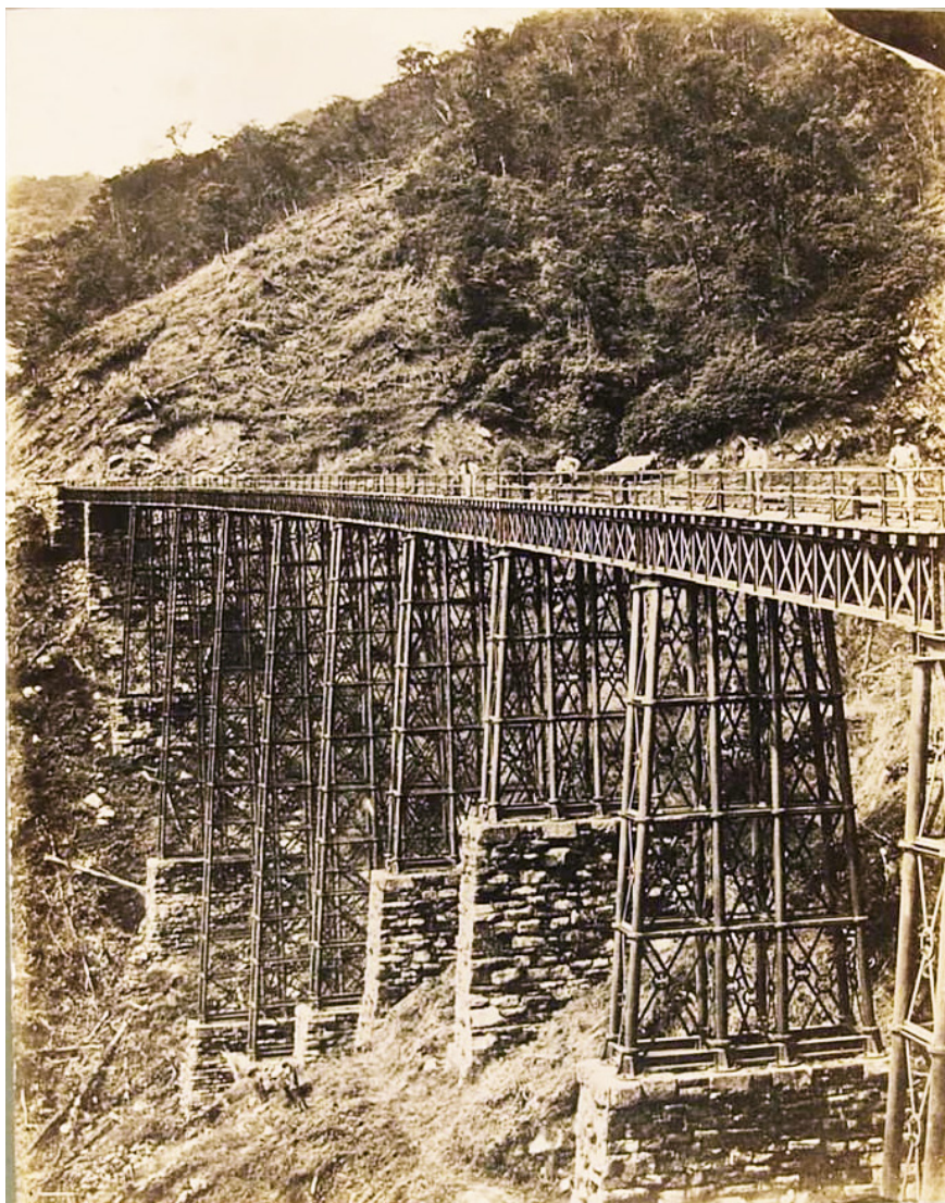
Figura 12 – Militão Augusto de Azevedo. Viaduto da Grota Funda (c.1868).
