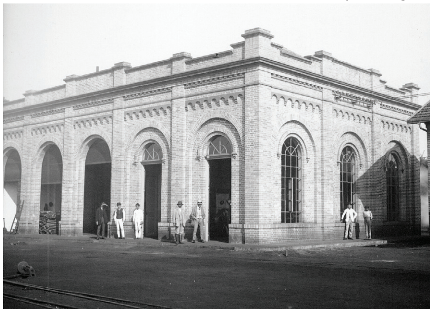
Figura 15. Usina de geração de energia no pátio de Ribeirão Preto. Companhia Mogiana.
