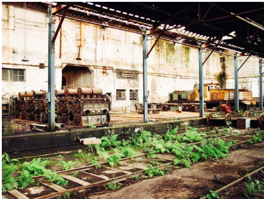
Figura 6. Área Interna do Complexo FEPASA
