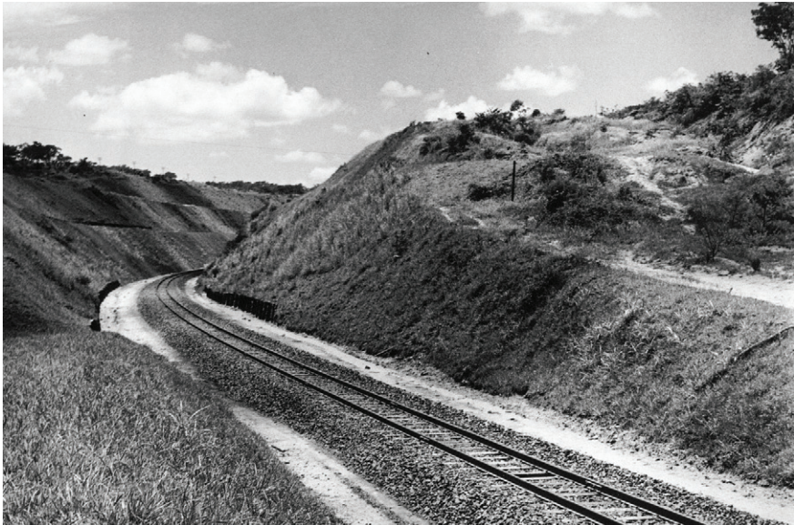
Figura 14. Aterro da Variante Tambaú-Bento Quirino, corte 35, Km 230. Companhia Mogiana.
