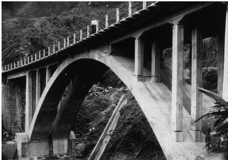
Figura 7 – Cimbramento da Ponte n. 16. Linha Mairinque a Santos (1936).
