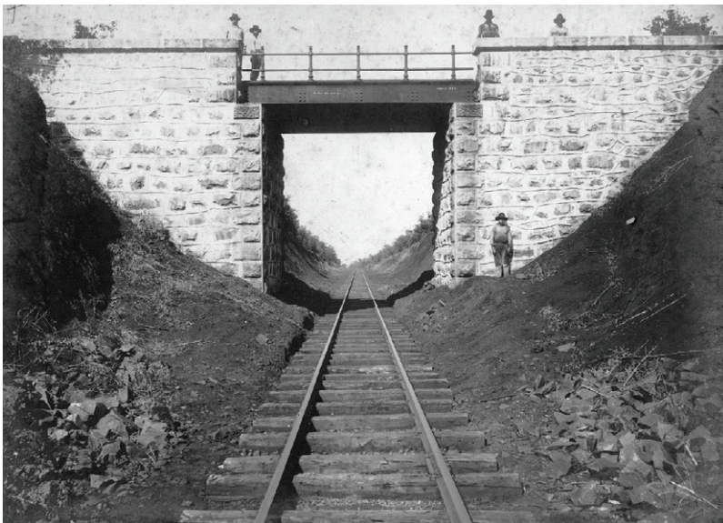
Figura 10 – Término de construção da passagem superior, em alvenaria e ferro, km 104. Companhia Mogiana (19??).
