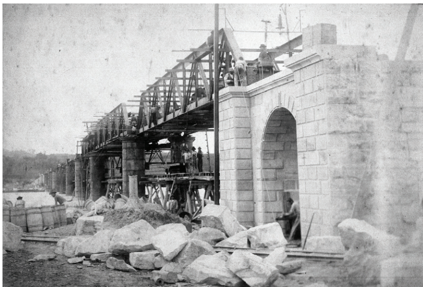
Figura 5 – Ponte sobre o Rio Tietê. Montagem da estrutura de ferro (1902-3).
