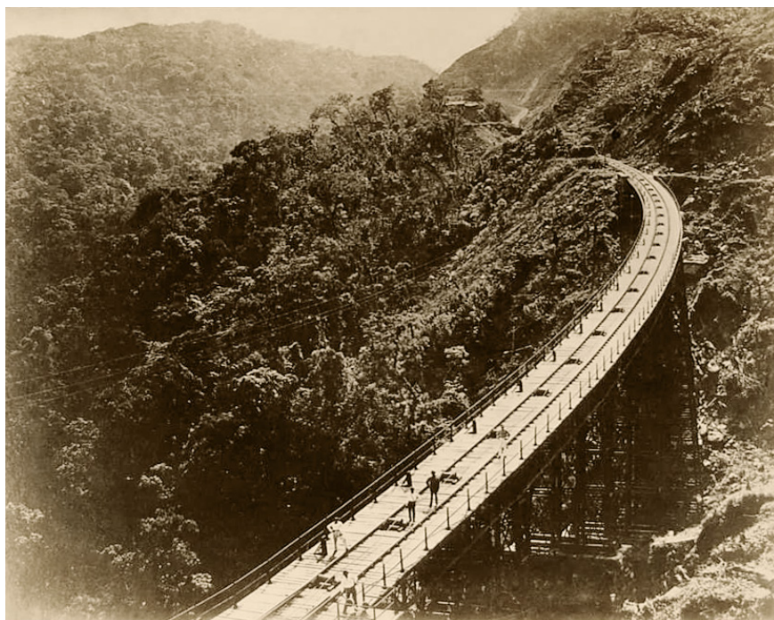
Figura 13 – Augusto Militão de Azevedo. Viaduto da Grota Funda (c.1865).
