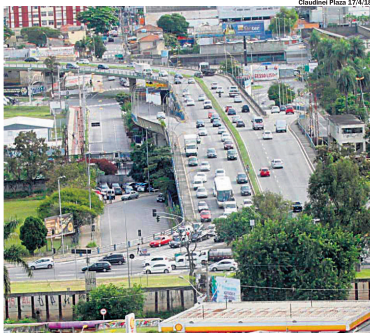
VIADUTO. Projeto viário inclui a revitalização do Castelo Branco
