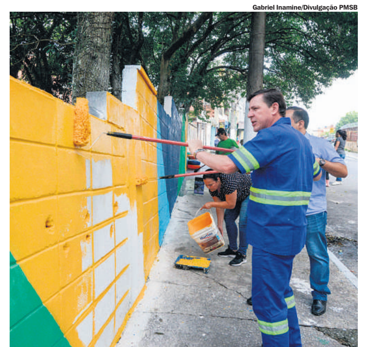
NOVA CARA. Muro na Rua Maria Adelaide Lima Quelha ganhou pintura
