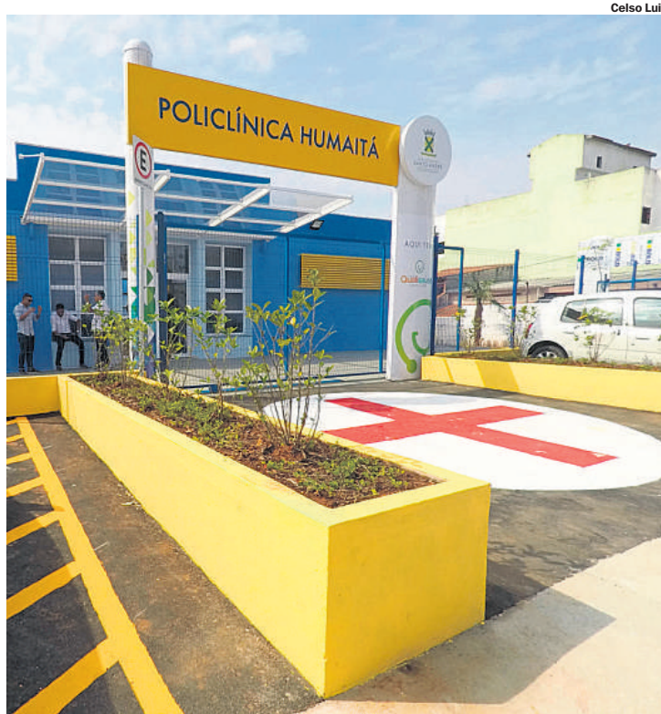
MODERNIZAÇÃO. Antiga UBS, unidade foi reformada e ampliada
