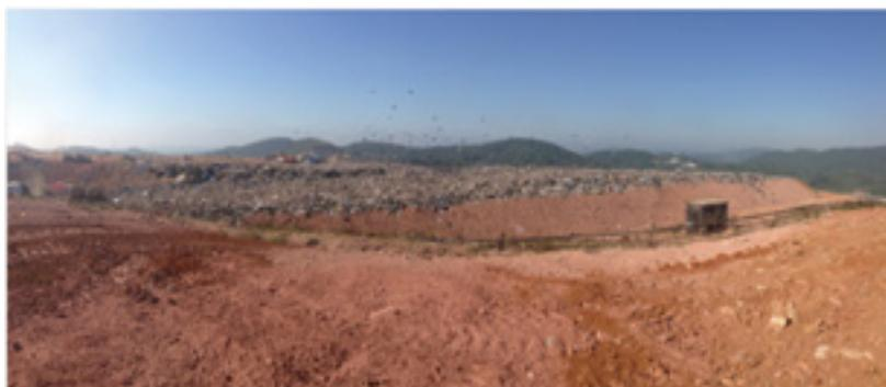
*Figura 2.27 - Aterro inadequado, resíduos descobertos*
