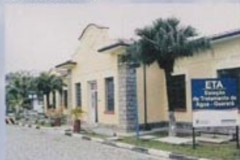
ETA - Estação de Tratamento de Águas do Guaratã
