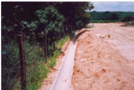
**FIGURA 13** - DRENAGEM DE ÁGUAS PLUVIAIS EM ATERRO SANITÁRIO.
