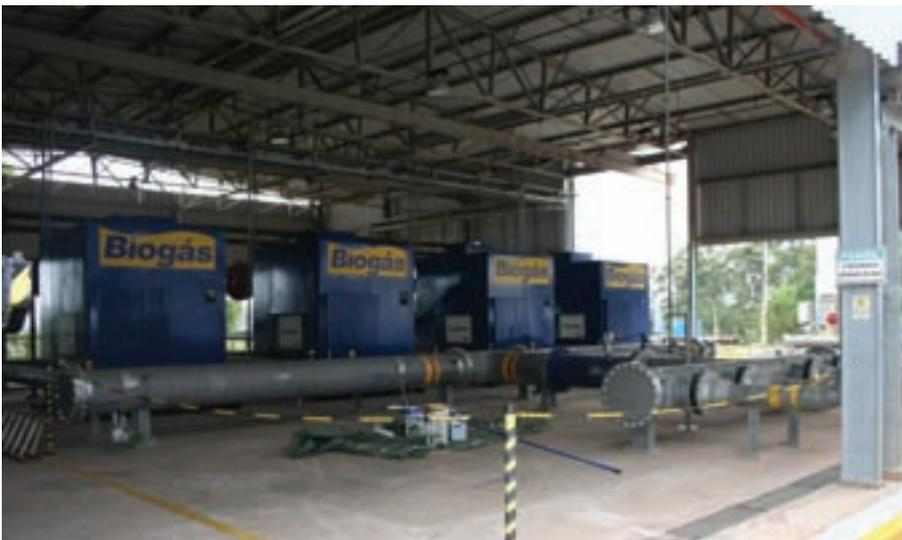
**FIGURA 19-** SISTEMA DE RECUPERAÇÃO ENERGÉTICA DE GÁS DE ATERRO
