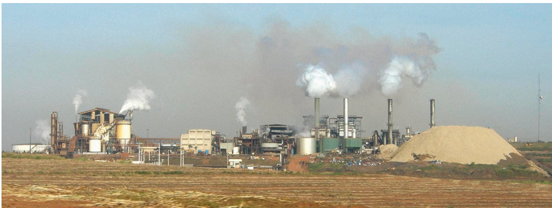
Figura 16 - Usina com caldeiras alimentadas com bagaço e palha de cana. Nota-se o monte de resíduos de cana aguardando queima nas caldeiras à direita. Fotografia de Rodrigo Campanha.
