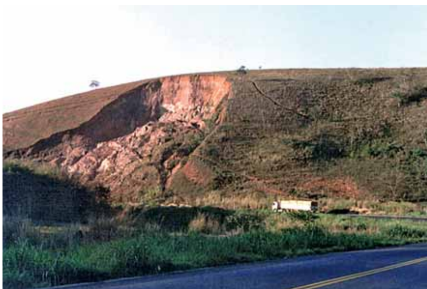
Foto 45 - Fenômeno de movimento de massa deu origem à voçoroca cujo material coluvial sofreu deslizamento, bloqueou a rodovia e expôs o regolito constituído de rochas metamórficas com foliação paralela ao talude do corte da estrada em Cataguases, MG.
