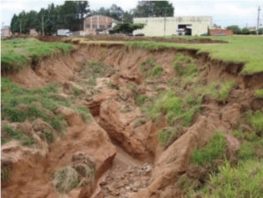
Boçoroca em Avaré (Janeiro de 2010). Foto: Acervo IG.
