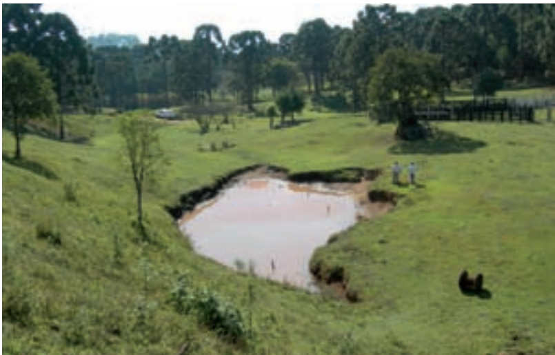
Subsidência em terreno cárstico em Bom Sucesso do Itararé (Junho de 2006). Foto: Acervo IG.
