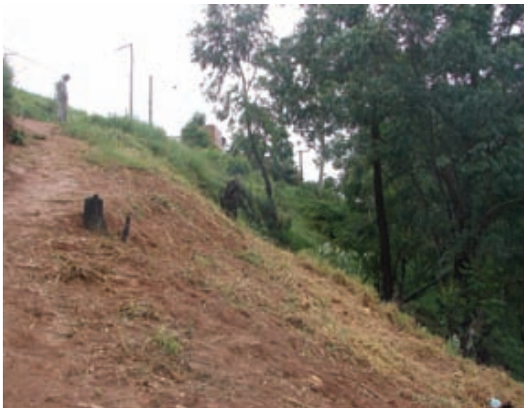
Áreas com solo exposto em Atibaia, afetadas por erosão laminar. (Janeiro de 2010). Foto: Acervo IG.
