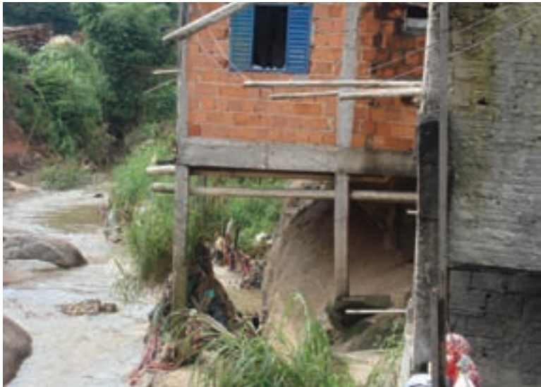
Moradias instaladas em curso d'água com disposição de lixo. Carapicuíba (Janeiro de 2010). Foto: Acervo IG.
