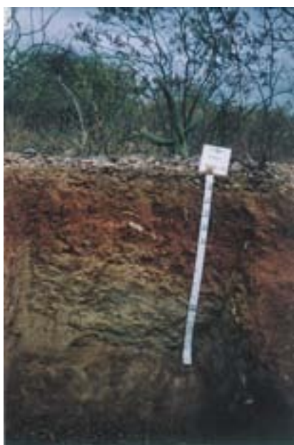
Foto 200 - LUVISSOLO CRÔMICO Órtico solódico. Cabrobó - PE. Antônio José Wilman Rios
