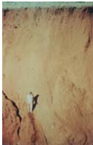
Foto 134 - Erosão em voçoroca. Jataí - GO.
