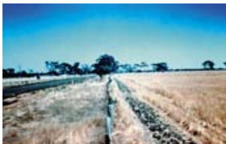
Foto 150 - Desalinhamento de mourões de cerca em área de VERTISSOLO. Eswaran e outros (1999).
