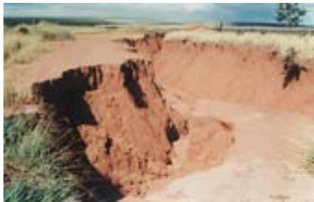
Foto 132 - Erosão em voçoroca. São Gabriel d'Oeste - MS.
