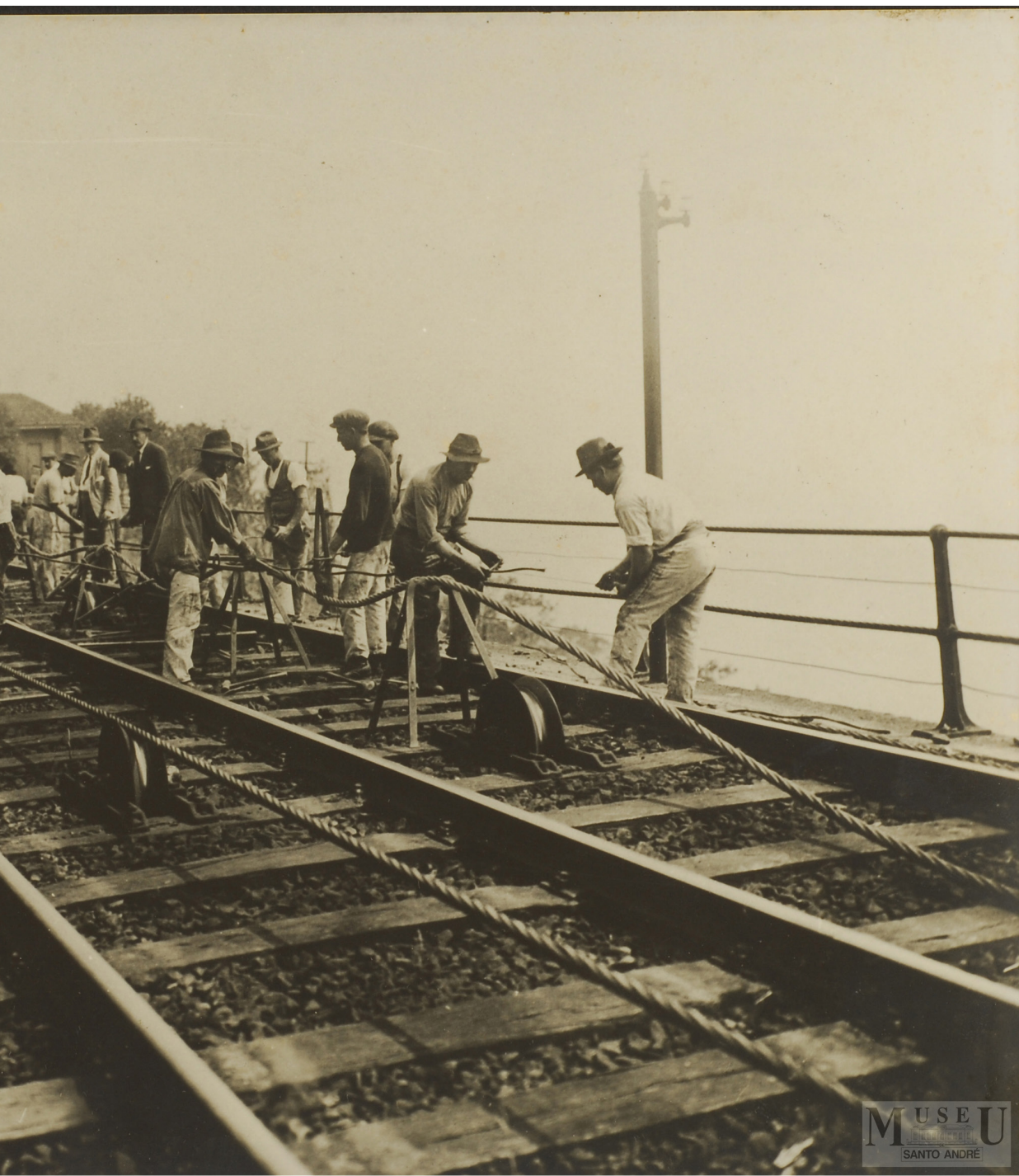
Montagem de cabos de aço nos Planos Inclinados da Serra, 1922. Coleção SPR. Foto de Octaviano Armando Gaiarsa.
