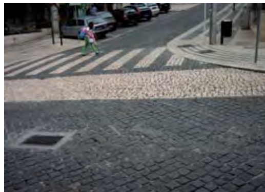
Calçadas e faixas de pedestres utilizando material em cores diferentes. Guimarães, Portugal. 2011. Foto: George Alex da Guia.
