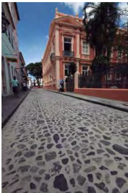
Vista de via com revestimento em pedra nivelada. Salvador/BA. 2014. Acervo: Governo do Estado da Bahia.
