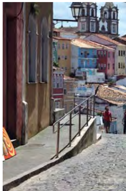
Calçada acessível com corrimão e guarda-corpo metálico. Salvador/BA. 2014. Acervo: Governo do Estado da Bahia.
