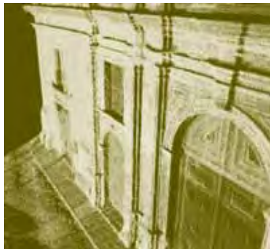
Fig. 4.26 – Nuvem de pontos da fachada da Igreja de São Francisco (Fonte LCAD).
