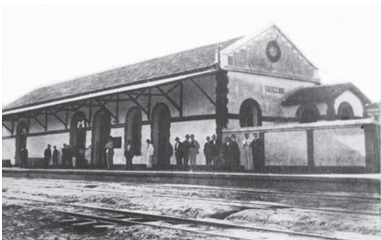
FIGURA 22 – A segunda estação de General Glicério, erguida em alvenaria de tijolos, no início da década de 1920. Foto de 1922 (Museu Ferroviário Regional de Bauru).
