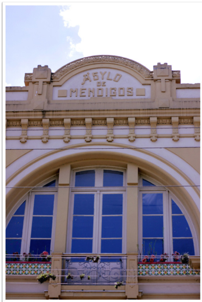
Figura 7: Detalhe da fachada do Asylo de Mendigos de Pelotas.
