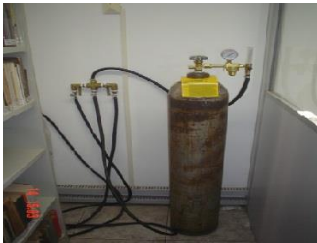
FIGURA 4 – Instalação do tubo de N 2 para desinfecção das obras
