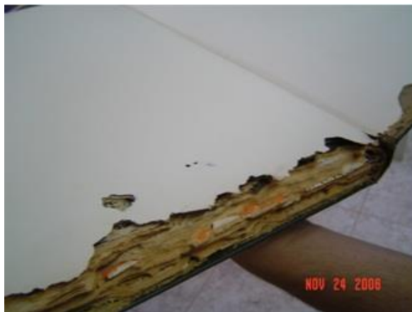
FIGURA 1 – Obra com broca
