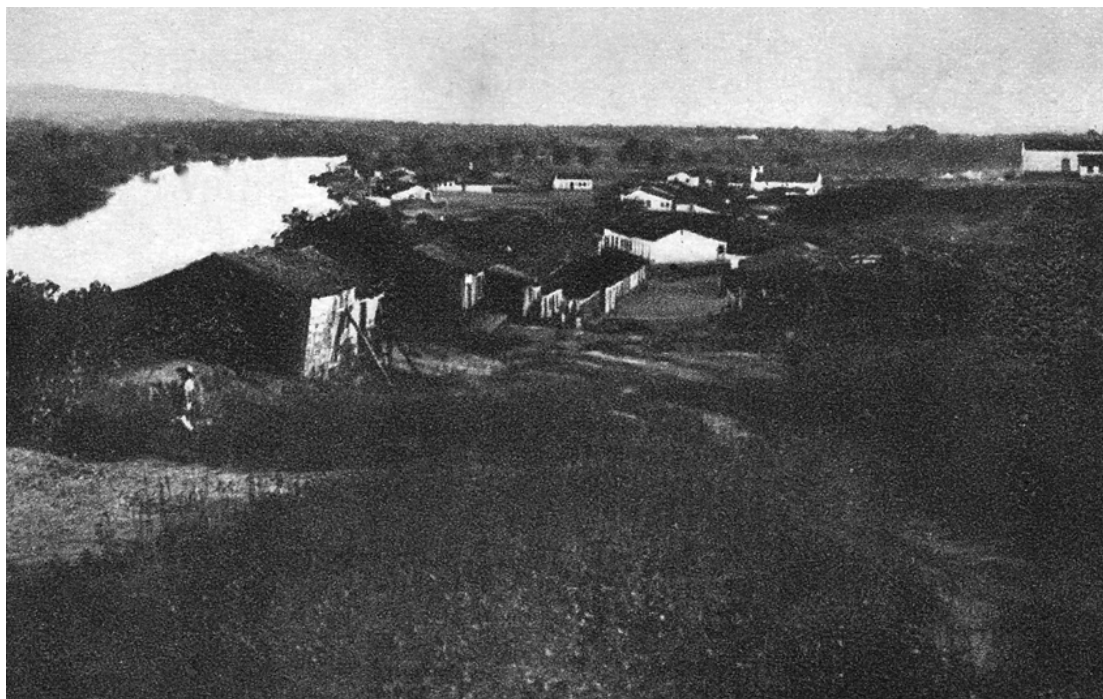
Fig.29 – Lapa viewed from the mountain. Photo originally published in Plate 15. Vista de Santa Maria tirada do rio Corrente. Imagem originalmente publicada em Estampa 15.
