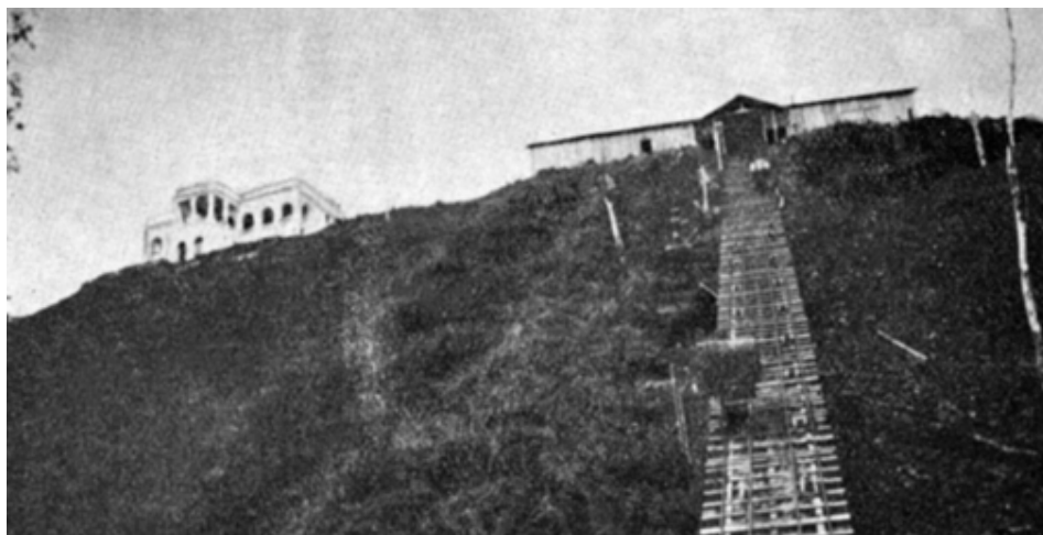
Fig.49 – House and cable railway in Porto Mendes. A three tons boiler being hoisted up from the river. Casa de residência e funicular em Porto Mendes. Vê-se o transporte de uma caldeira pesando 3 toneladas. Fig.46 da Estampa 42.
