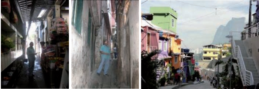
Figura 27 – Rua 4 antes e depois da obra
