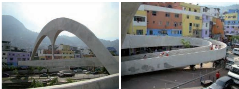
Figura 30 – Passarela sobre a Lagoa-Barra
