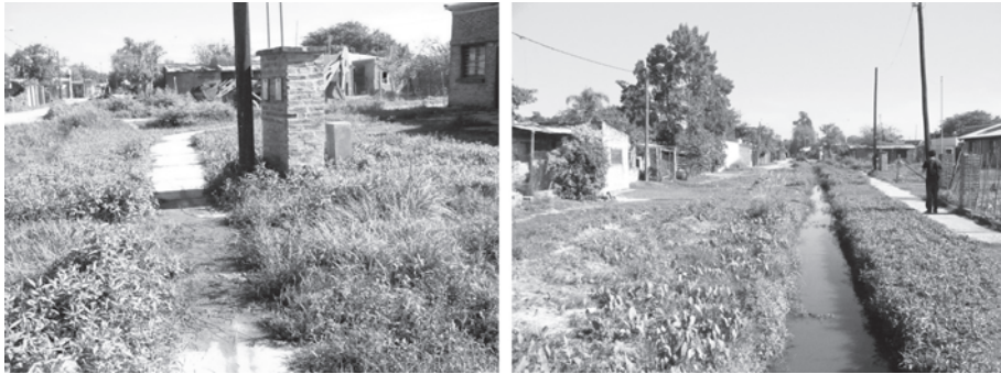
Figura 9 – Red peatonal con efluentes cloacales (izq.) y calle sin abrir al tránsito vehicular (der)
