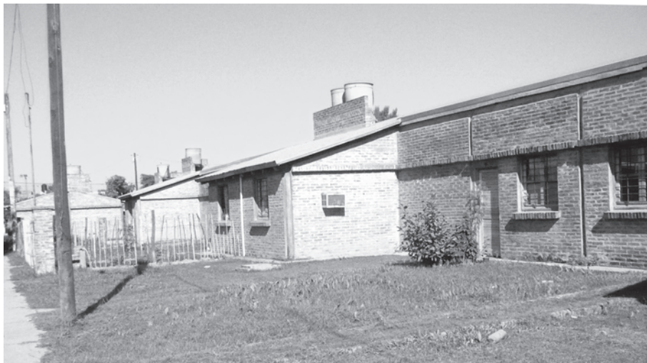
Figura 4 – Frente de las viviendas del barrio Vargas II construidas por el programa
