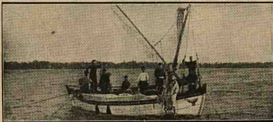
Esta gravura representa a descida de um escaphandro para a pesca das esponjas. Chegado ao ponto em que ha esponjas, o bote lança ancora e o escaphandro, munido de uma faca de lamina afiada, desce para a pesca. Póde, assim, trabalhar muito tempo debaixo d'agua, mas não consegue descer a mais de trinta metros de profundidade, em virtude da forte pressão da camada d'agua que o incommoda.
