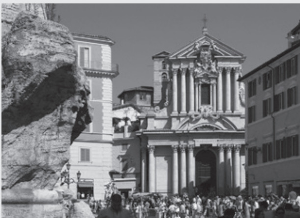
180. Fachada de Santi Vincenzo e Anastasio, obra de Martino Longhi, il Giovane (1602-1660), concluída em 1650. É impressionante a concentração das três colunas (a cada lado) justapostas em planos salientes – bem como de frontões e tímpanos interpenetrantes – para marcar o eixo central e o acesso ao templo. Fonte: Fotografia elaborada pelo autor (2007).
