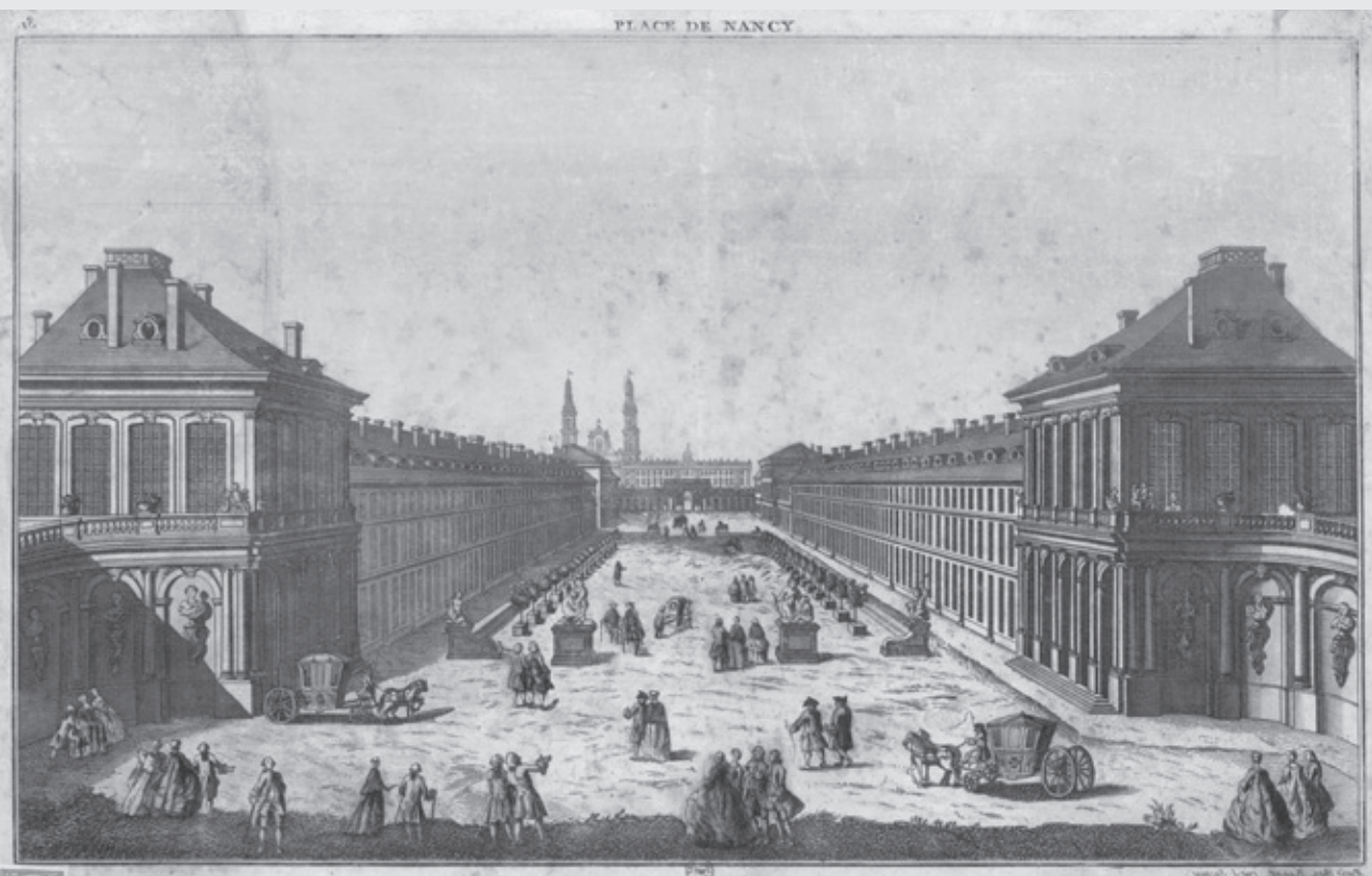
116. Vue Meridionale de la grande Place dite la Carriere a Nancy. Após as intervenções de abertura e remodelamento das praças. Estampa de 1785. Fonte: Biblioteca Nacional da França.
