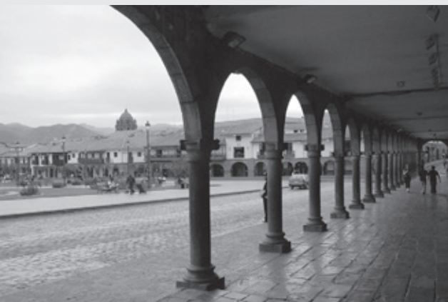
351. Edifícios com galerias porticadas da Plaza de Armas de Cusco. O espaço seria animado, dramaticamente, pela Catedral e pela igreja dos jesuítas. Fonte: Fotografia elaborada pelo autor (2007).
