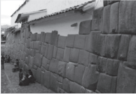
333. Casarões coloniais cusqueños construídos acima de alicerces e de muros incas remanescentes. Fonte: Fotografia elaborada pelo autor (2007).
