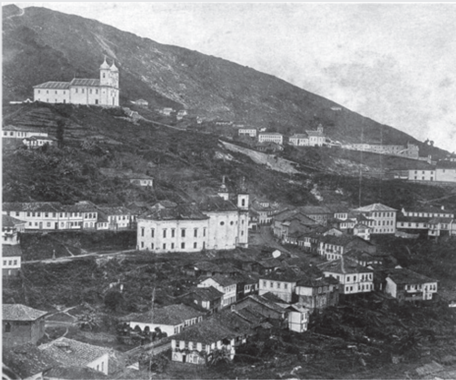
257. Panorama do Bairro do Rosário em 1875. Reparar a relação entre a mancha edificada, os monumentos livres de edificações e a paisagem natural. Em destaque, a Igreja de Nossa Senhora do Rosário (abaixo), a Igreja de São Francisco de Paula (acima) e a Igreja de São José (à direita). Fonte: Acervo IFAC/UFOP.
