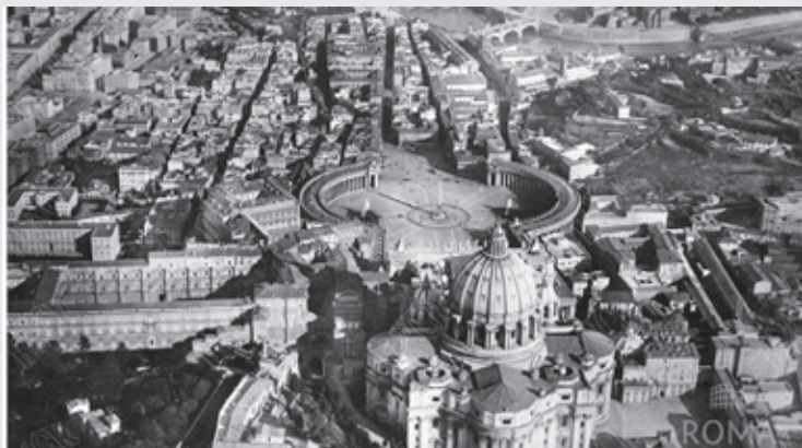
247. O complexo de San Pietro e a spina dos Borghi vistos em uma fotografia aérea de 1929. Notar a Via del Borgo Vecchio, à direita, e a Via del Borgo Nuovo, à esquerda. Fonte: Site Roma ieri oggi.
