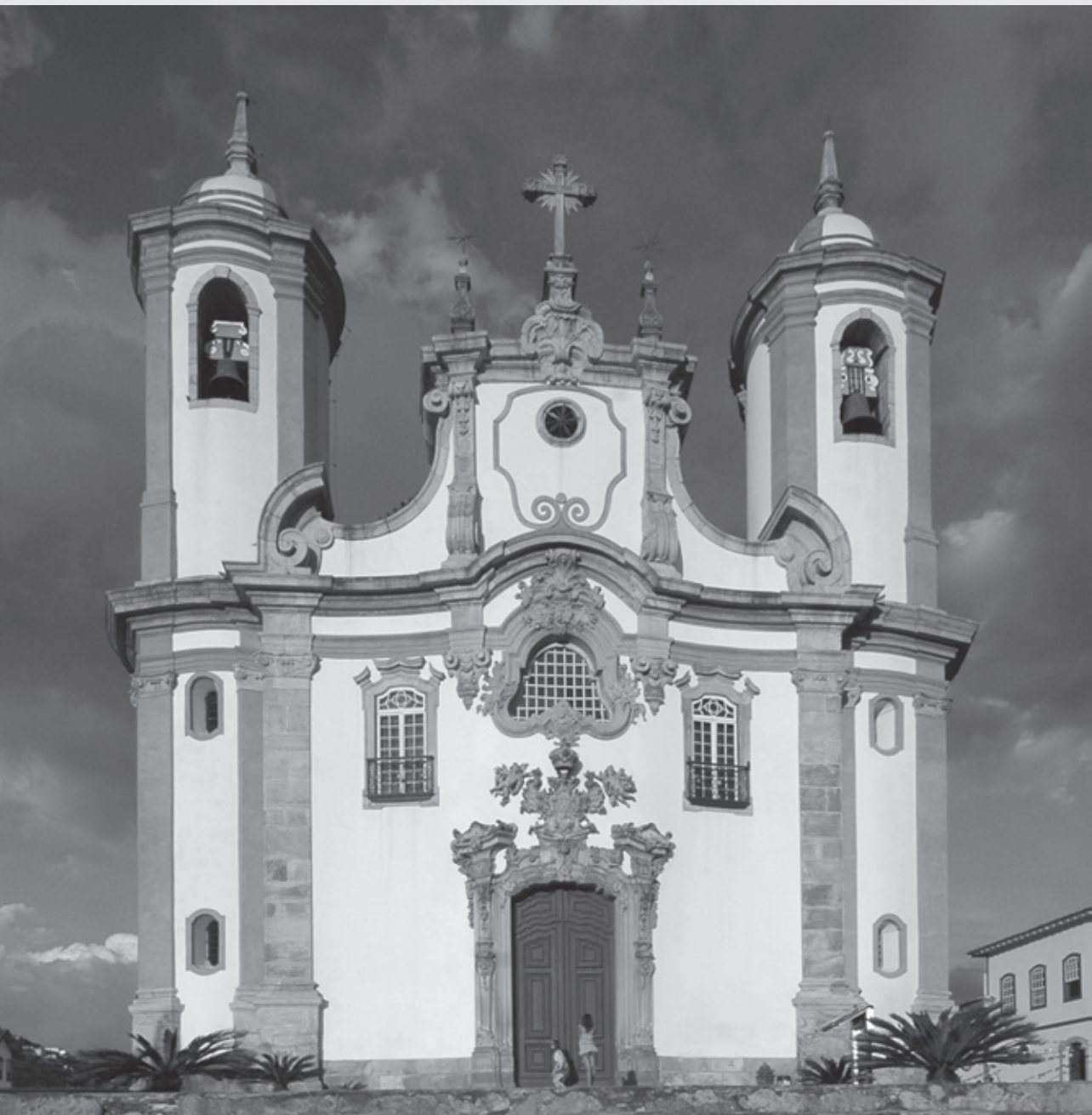
283. Fachada principal da Igreja da Ordem Terceira de Nossa Senhora do Carmo. Fonte: Fotografia elaborada pelo autor (2008).
