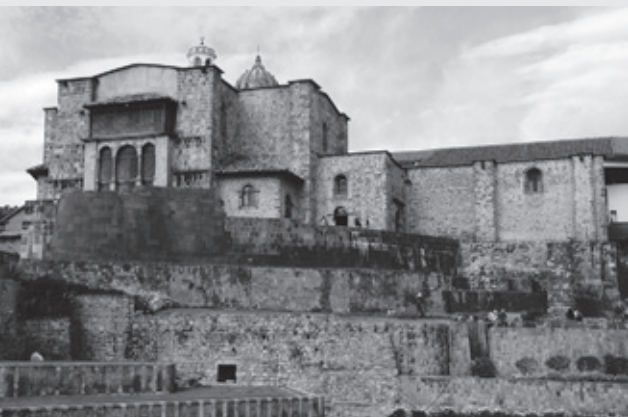
374. Dramática imagem da face posterior da Igreja do Convento de Santo Domingo, em Cusco, desvelando a justaposição do presbitério do edifício católico acima da plataforma encurvada dos fundos do Templo de Coricancha. Fonte: Fotografia elaborada pelo autor (2007).
