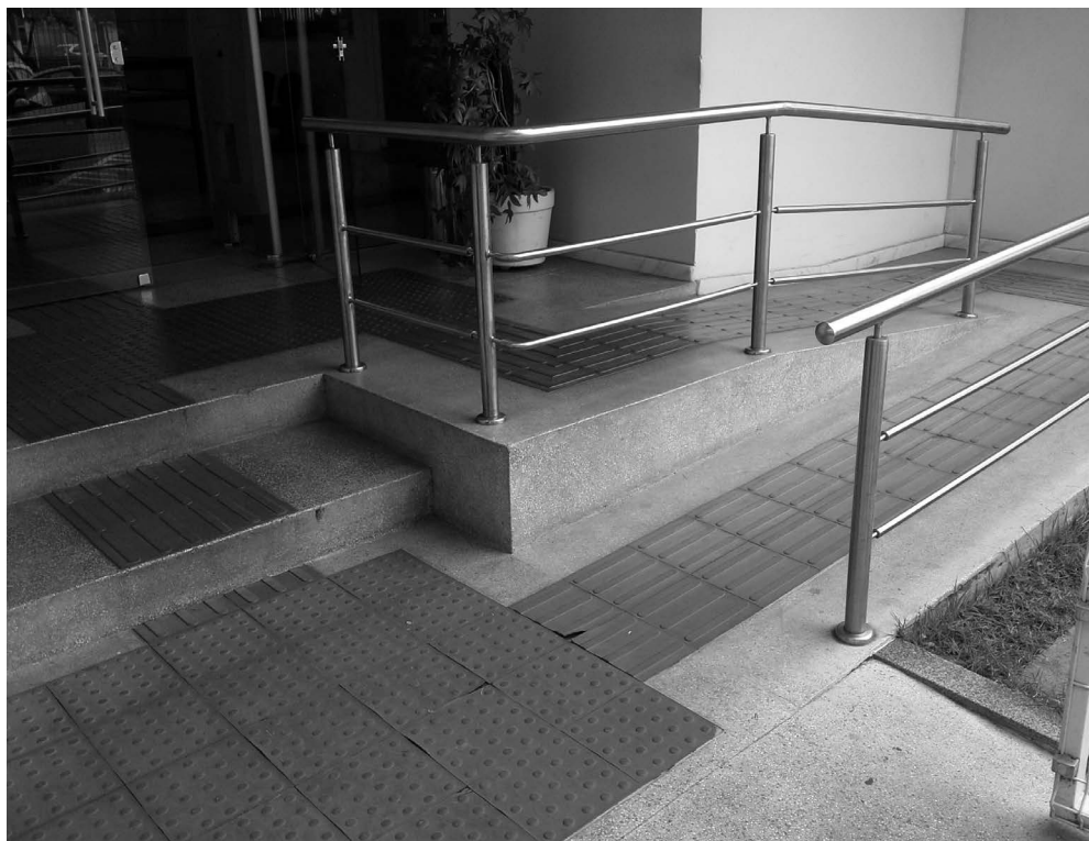
Rampa adaptada com corrimão e piso tátil na Biblioteca Pública Estadual do Espírito Santo
