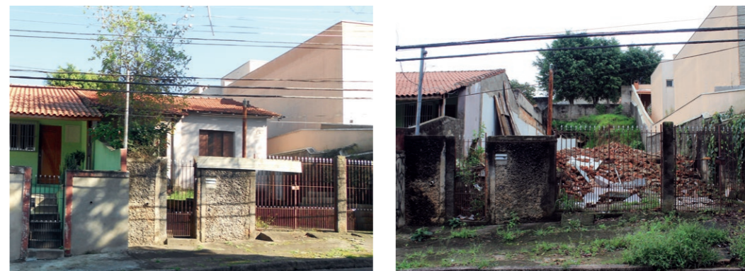
74. Tipologia A2, localizada na R. Gonzaga Franco, em julho de 2015, quando ainda estava edificada e, posteriormente, em maio de 2017, quando já havia sido demolida. <<
