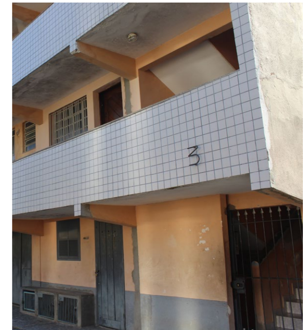
Figura 89: vista parcial da fachada principal. No primeiro plano da fachada foi adicionado revestimentos cerâmico.
