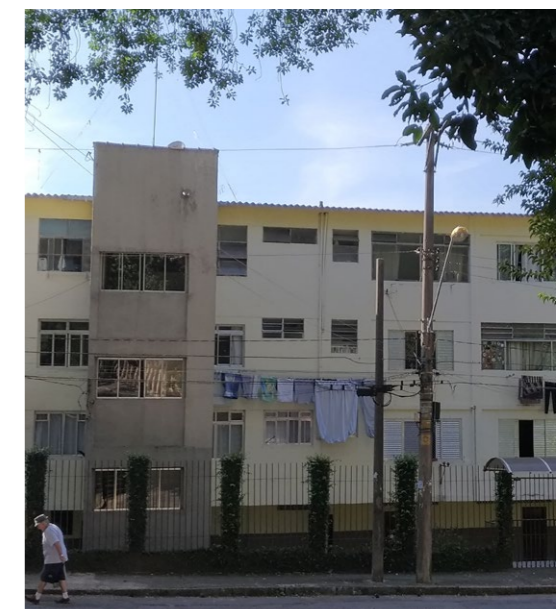
Figura 122: fachada posterior em 2017, com a presença de esquadrias na caixa de escada.
