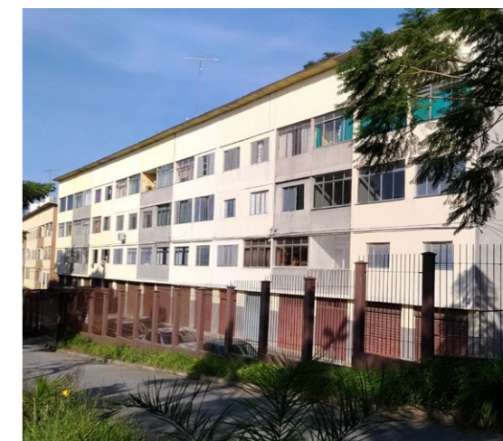
Figura 124: vista da fachada principal.
