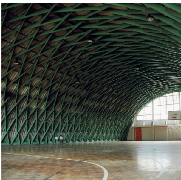
45. Vista interna do ginásio em 2006, onde é possível perceber sua estrutura de madeira.
