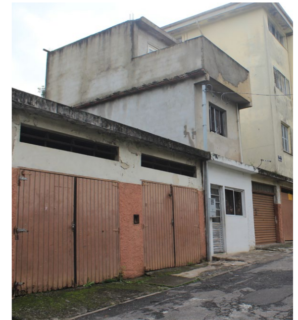
Figura 111: situação recente (2017) dos anexos construídos.
