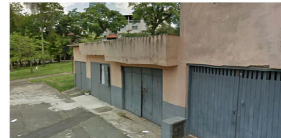
Figura 90: aspecto frontal dos anexos.
