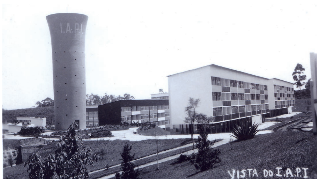
41. Vista parcial dos prédios da tipologia HC. >>
