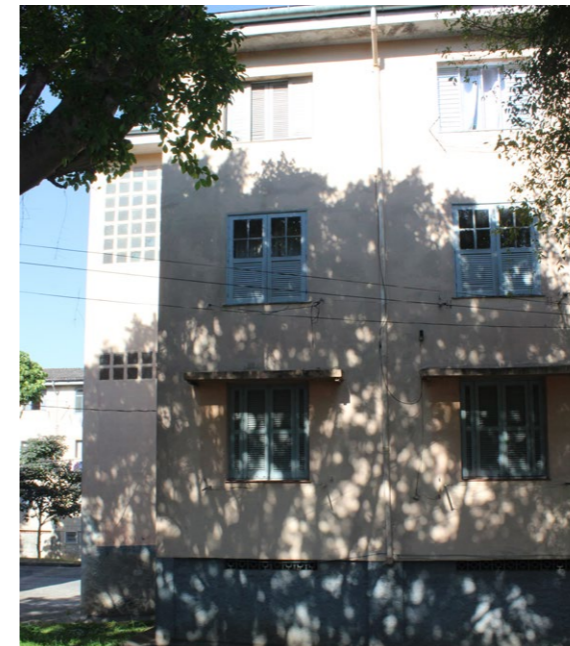
Figura 88: vista parcial da caixa de escada e da fachada posterior.
