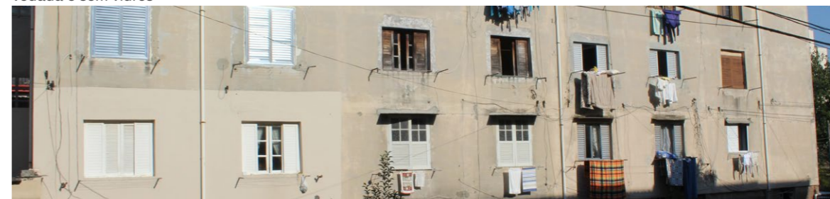
Figura 105: vista parcial da fachada posterior em que se nota a presença de janelas originais, janelas de reformas antigas (são de madeira e de proporção semelhante as originais) e esquadrias completamente diferentes.
