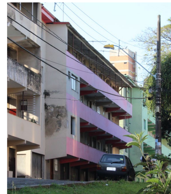
Figura 93: nos pavimentos 1 e 2 ocorreu a expansão do apartamento para o corredor de acesso às unidades.
