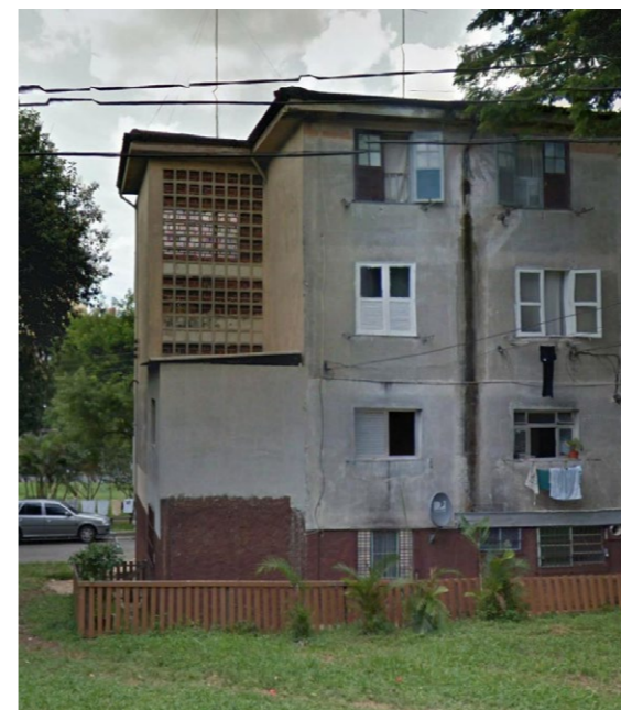
Figura 95: vista parcial da fachada posterior em que se nota o anexo construído atrás da caixa de escada.
