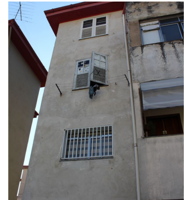
Figura 107: de cima para baixo observa-se exemplos de janela original modificada, janela original e esquadria trocada.
