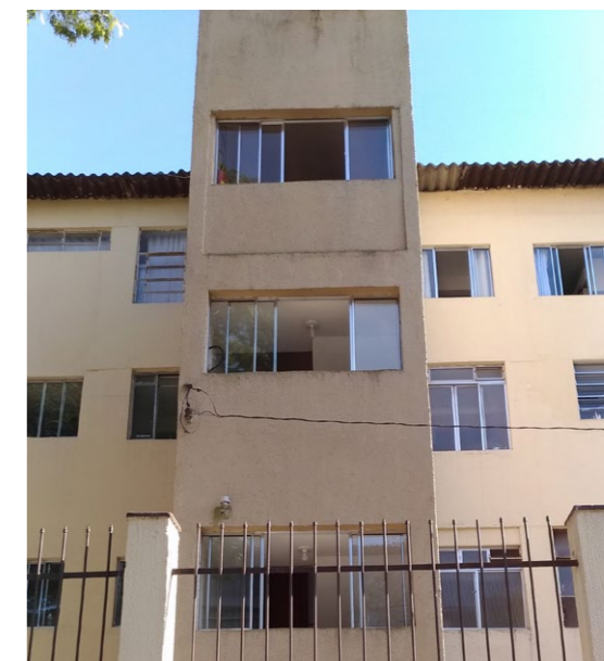
Figura 118: vista parcial da fachada posterior em que se nota a presença de janelas em uma das caixas de escada.
