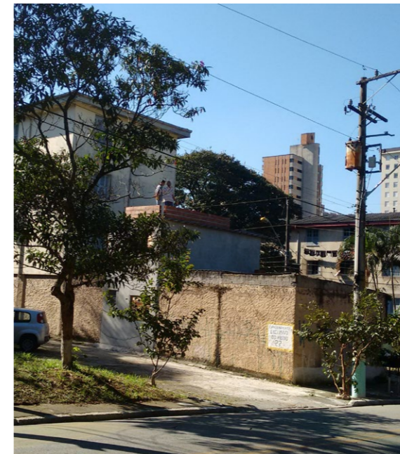
Figura 110: expansão, em altura, dos módulos anexos ao edifício em 2015.
