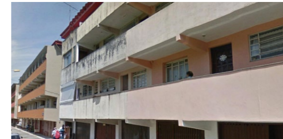
Figura 108: no final do corredor é possível observar a expansão dos apartamentos para o corredor de acesso.
