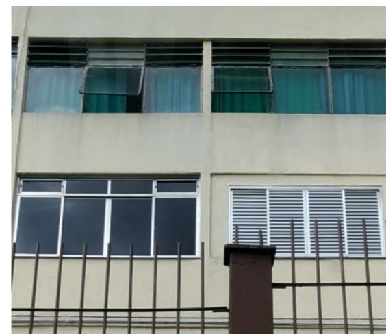
Figura 123: esquadrias originais presentes na fachada principal.
