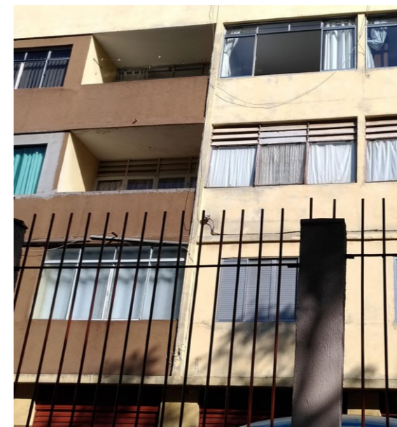
Figura 125: presença de varandas e de esquadrias originais na fachada principal.
