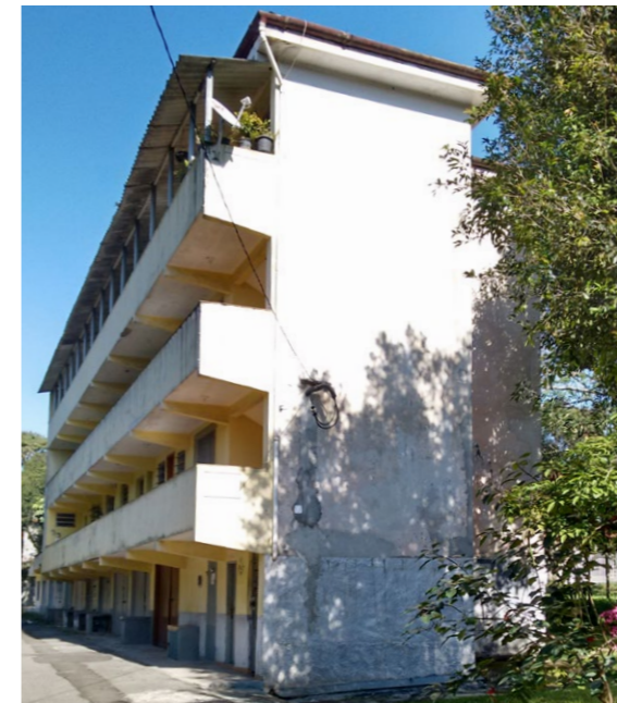
Figura 82: vista da lateral, livre, dos corredores de acesso aos apartamentos.
