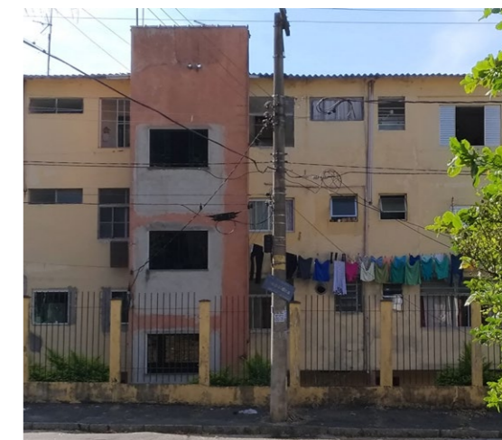
Figura 128: vista parcial da fachada posterior.
