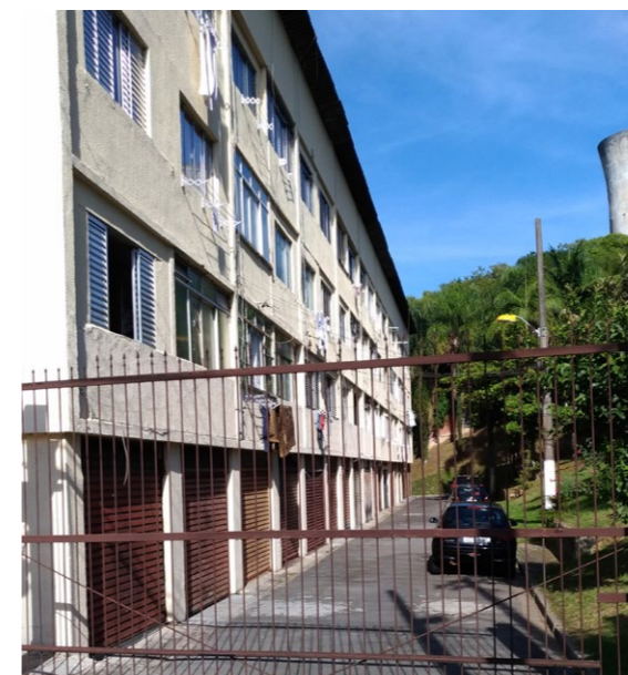
Figura 117: Fachada principal vista da rua. Ao fundo é possível ver parte de uma das caixas d'água construídas pelo IAPI.
