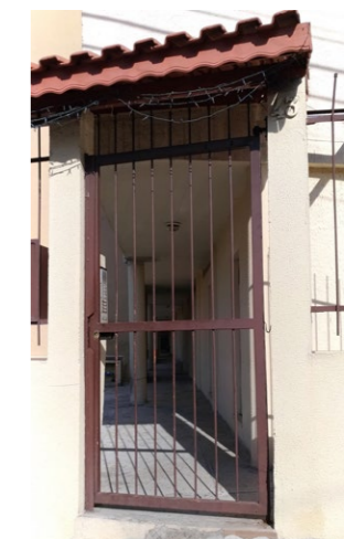
Figura 120: corredor de acesso às caixas de circulação vertical e aos vãos vedados do térreo.
