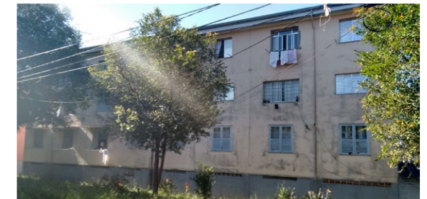
Figura 91: vista parcial da fachada posterior.
