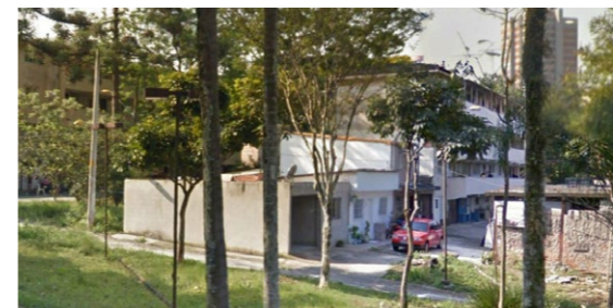
Figura 97: vista dos anexos construídos ao lado e na área em frente ao edifício.
