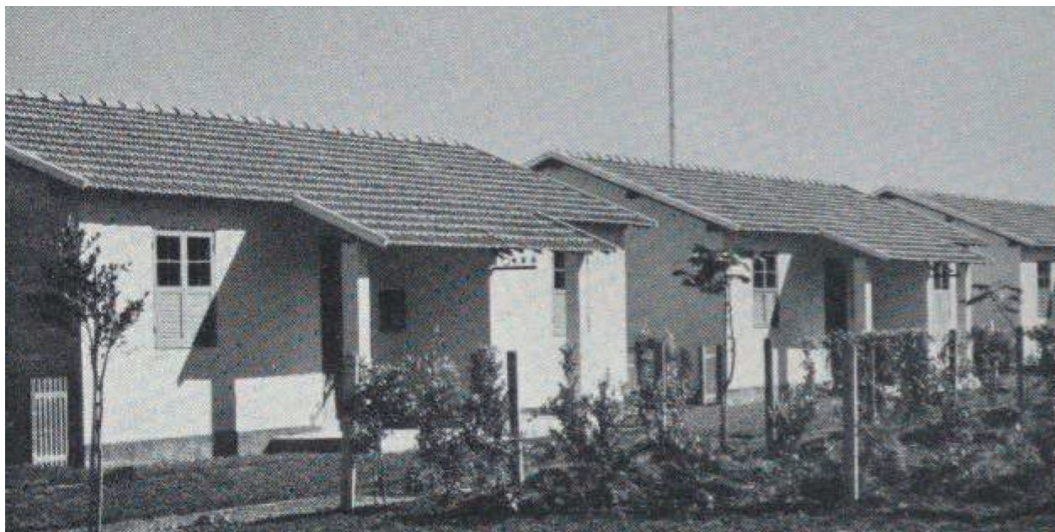
25. Vista da tipologia A1 edificada no Conjunto Residencial de Realengo. >>
