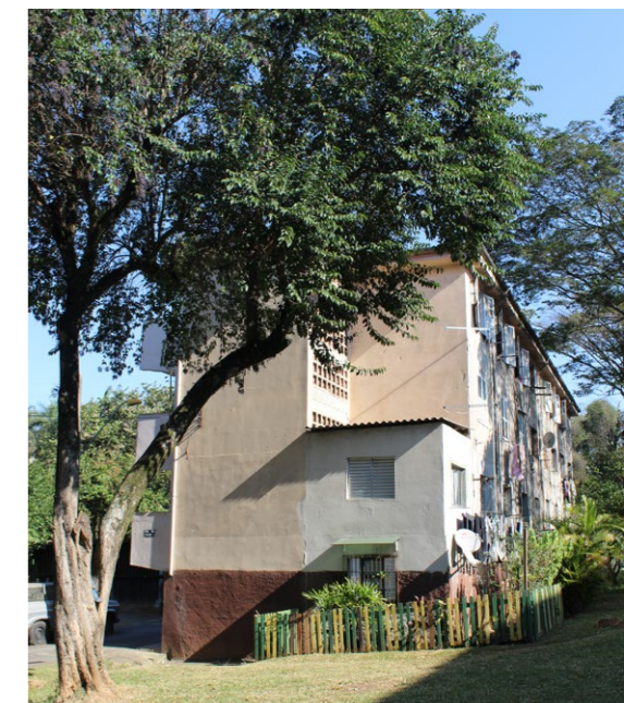
Figura 96: vista lateral do edifício e do anexo construído atrás da caixa de escada.
