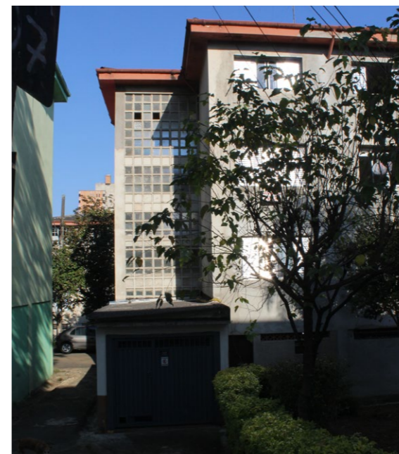
Figura 92: vista do anexo construído nos fundos da caixa de escada.
