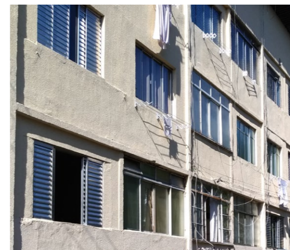
Figura 119: esquadrias de diferentes proporções na fachada principal.
