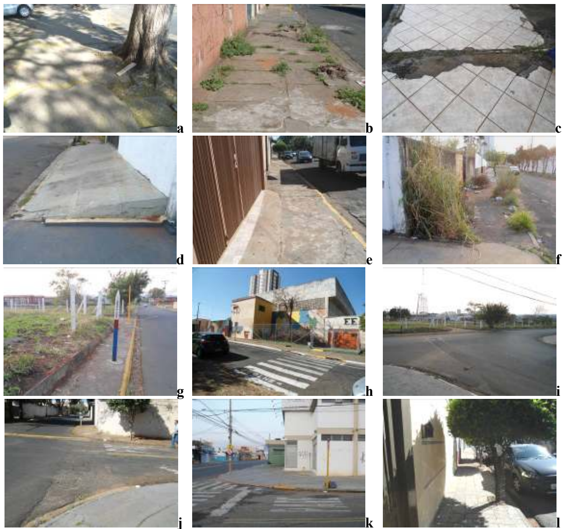
Figura 6. Problemas de microacessibilidade no entorno da Escola Estadual Luiz Zuiani. Estado de conservação das superfícies das calçadas (a, b, c), tipo de piso escorregadio (c), desnível superior a 1,5cm (d), obstáculos nas calçadas (e, f), largura efetiva irregular (g), ponto de ônibus sem cobertura (g), ausência de rampa de travessia (h), ausência de faixa de pedestres (i, j), estacionamento invadindo espaço das calçadas (k), altura máxima inferior a 2,10m (l)
