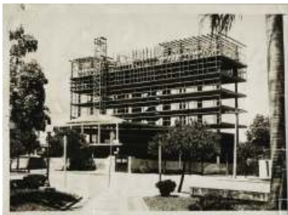
Figura 5. O Paço Municipal em Construção, por volta de 1958. (Marília, 2015)
