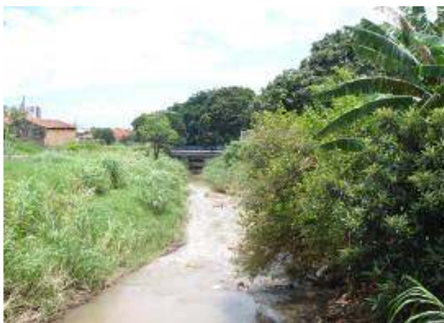
Figura 2. Ponte sobre o Ribeirão Lavapés, Botucatu-SP, 2014
