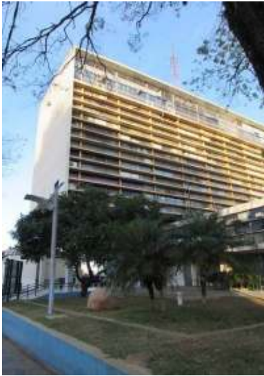
Figura 10. A fachada Oeste do Paço Municipal, em 2015
