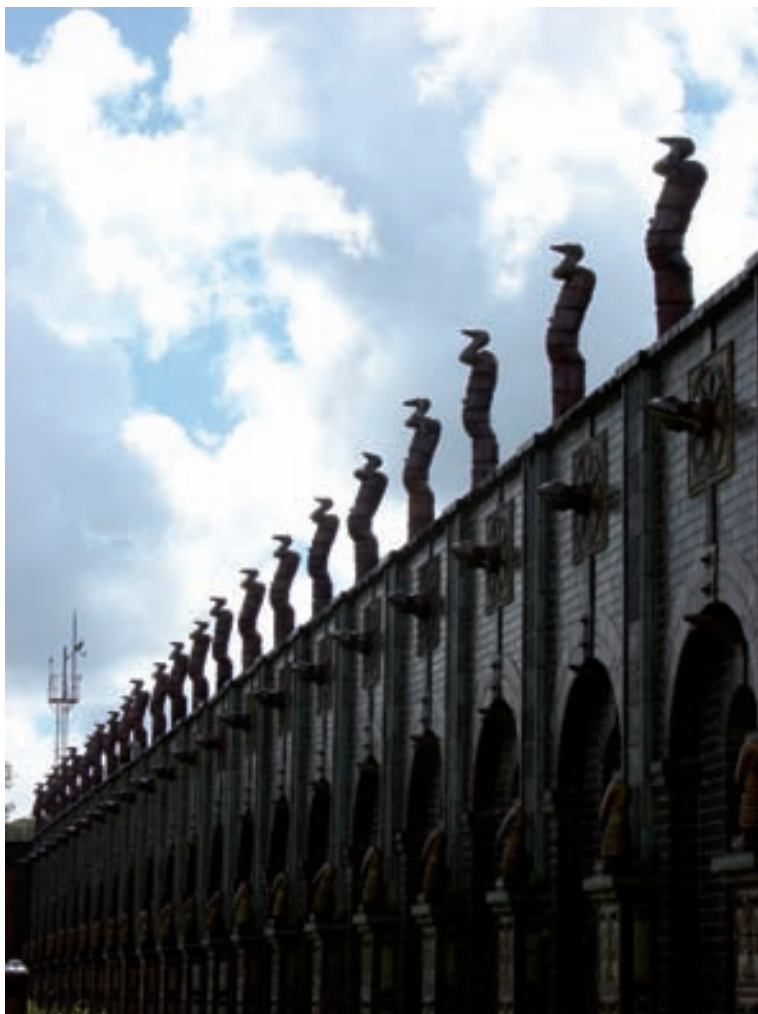
Figura 23 – Francisco Brennand, “Pássaros Rocca”, esculturas colocadas sobre os muros da Oficina Brennand, protegem o local (foto da autora).
