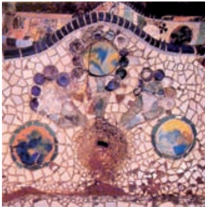
Figuras 11 e 12 – Antoni Gaudí, “Parque Güell” (detalhes), técnica catalã trencadis, pedaços de azulejos e vidros coloridos. Fonte: Zerbst, 2005, p.155.
