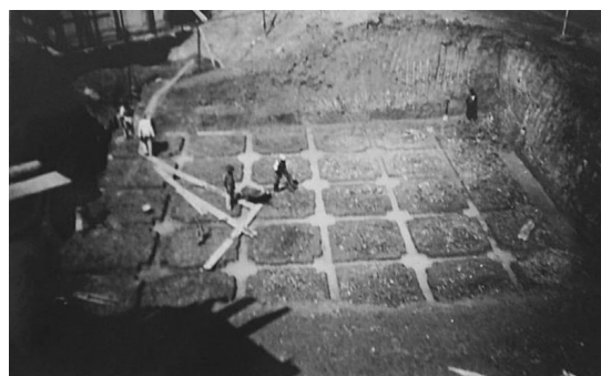
Fotografia 39 - Quadra 16 - Fundação da caixa d'água subterrânea. Fonte: Arquivo INSS.
