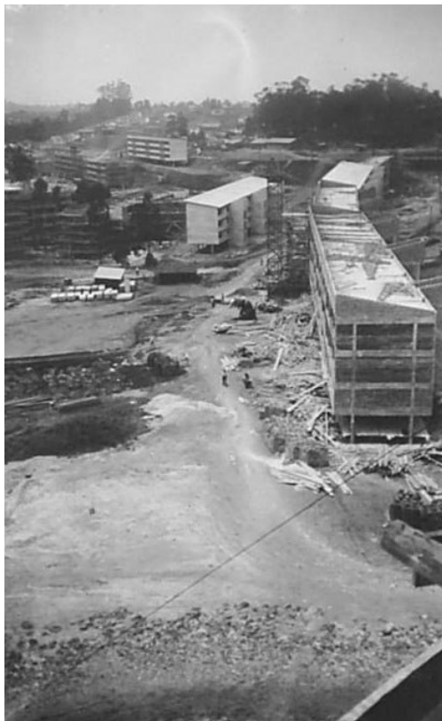
Fotografia 32 - Quadra 16 – Prédios 26,25,24,23,27,28 e 30. Fonte: Arquivo INSS. Relatório n° 06 da construção das quadras 8, 11 e 16. Outubro / 1950.
