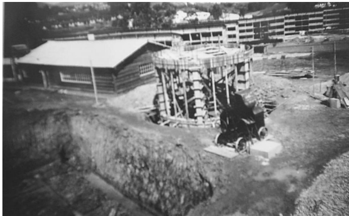
Fotografia 42 - Quadra 16 - Caixa d'água elevada. Fonte: Arquivo INSS.
