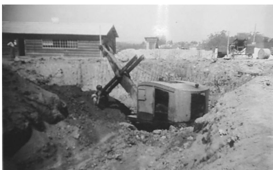
Fotografia 38 - Quadra 16 - Escavação da caixa d'água subterrânea. Fonte: Arquivo INSS.
