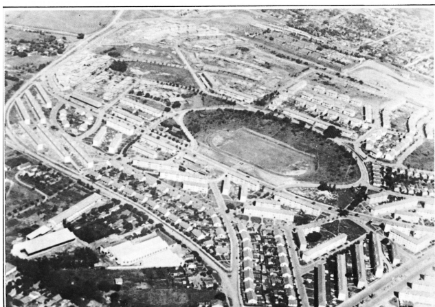
Visa aérea do Conjunto após o término das obras.
