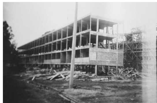
Fotografia 29 - Quadra 16 – Prédio 1. Fonte: Arquivo INSS.
