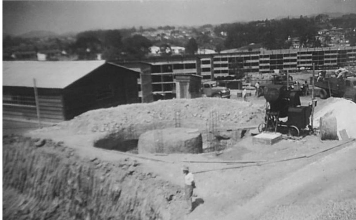
Fotografia 41 - Quadra 16 - Fundação da caixa d'água elevada. Fonte: Arquivo INSS.
