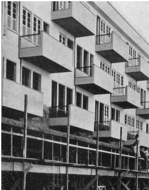
Fotografia 7 - Bloco de apartamentos do Realengo em construção.
