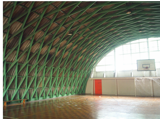
Fotografias 82 - Ginásio coberto e Fotografia 83 - detalhe da treliça de cobertura em madeira. Fonte: PESSOLATO, 2007.
