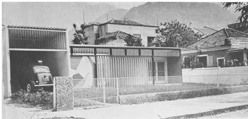
Fotografia 2. Fachada frontal da casa de campo. Fonte: Revista L'Architecture d'Aujourd'hui, 1952.
