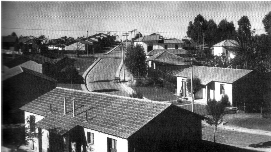
Fotografia 22 - Casas geminadas tipo A2 logo após a construção. Fonte: BONDUKI, 1998, p.191.
