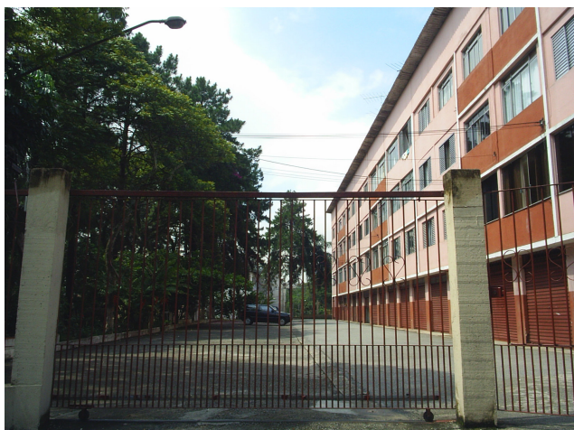
Fotografia 87 – Prédio da Creche. Fonte: PESSOLATO, 2007.
