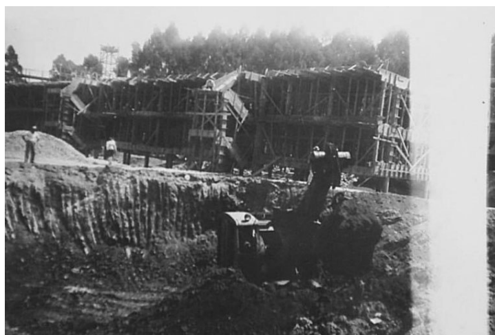
Fotografia 40 - Quadra 16- Escavação da caixa d'água subterrânea. Fonte: Fonte: Arquivo INSS.
