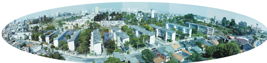
Fotografia 57 - Panorâmica do Conjunto IAPI – Trecho dos Prédios Novos. Fonte: RAMOS, 2003.
