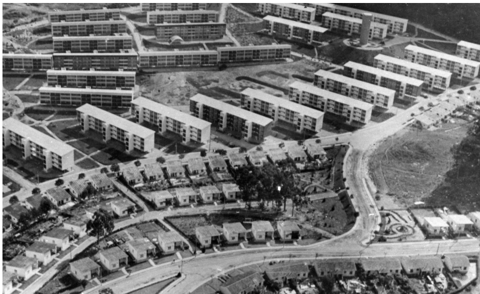
Fotografia 34 - Prédio do Conjunto Habitacional do IAPI, década de 1950. Coleção René Schoeps. Acervo Museu de Santo André.
