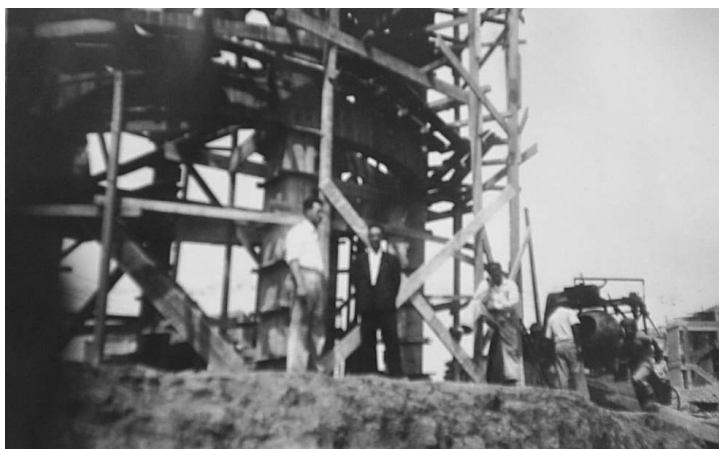
Fotografia 43 - Quadra 16 - Caixa d'água elevada. Fonte: Arquivo INSS.
