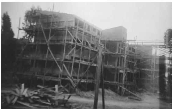
Fotografia 28 - Quadra 16 – Prédio 3. Fonte: Arquivo INSS.
