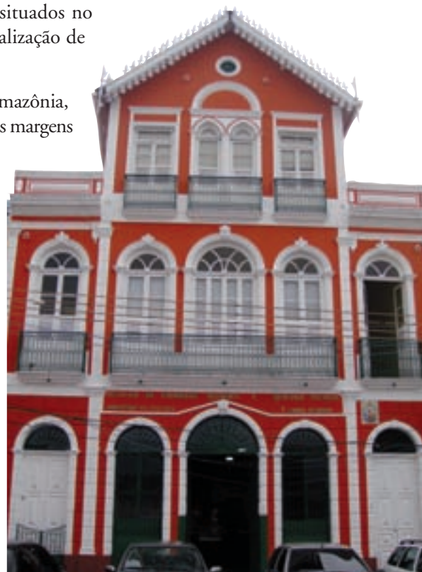
Sede do Iphan em Manaus. Foto: Arquivo Superintendência do Amazonas.
