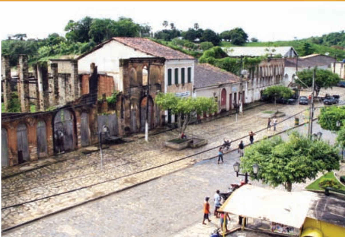
Patrimônio arruinado em Laranjeiras (SE). Foto: Arquivo Iphan.
