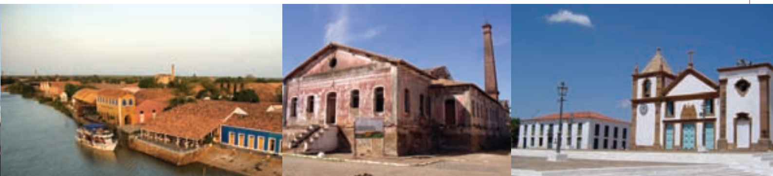
Parnaíba, cidade tombada em 2008. Foto: Margareth Leite/Arquivo Superintendência do Piauí. Fábrica de Manteiga e Queijo das Fazendas Nacionais, em Campinas do Piauí, em restauração. Foto: Ricardo Augusto/Arquivo Superintendência do Piauí. Praça da Matriz em Oeiras. Foto: Claudiana Cruz/Arquivo Superintendência do Piauí.
