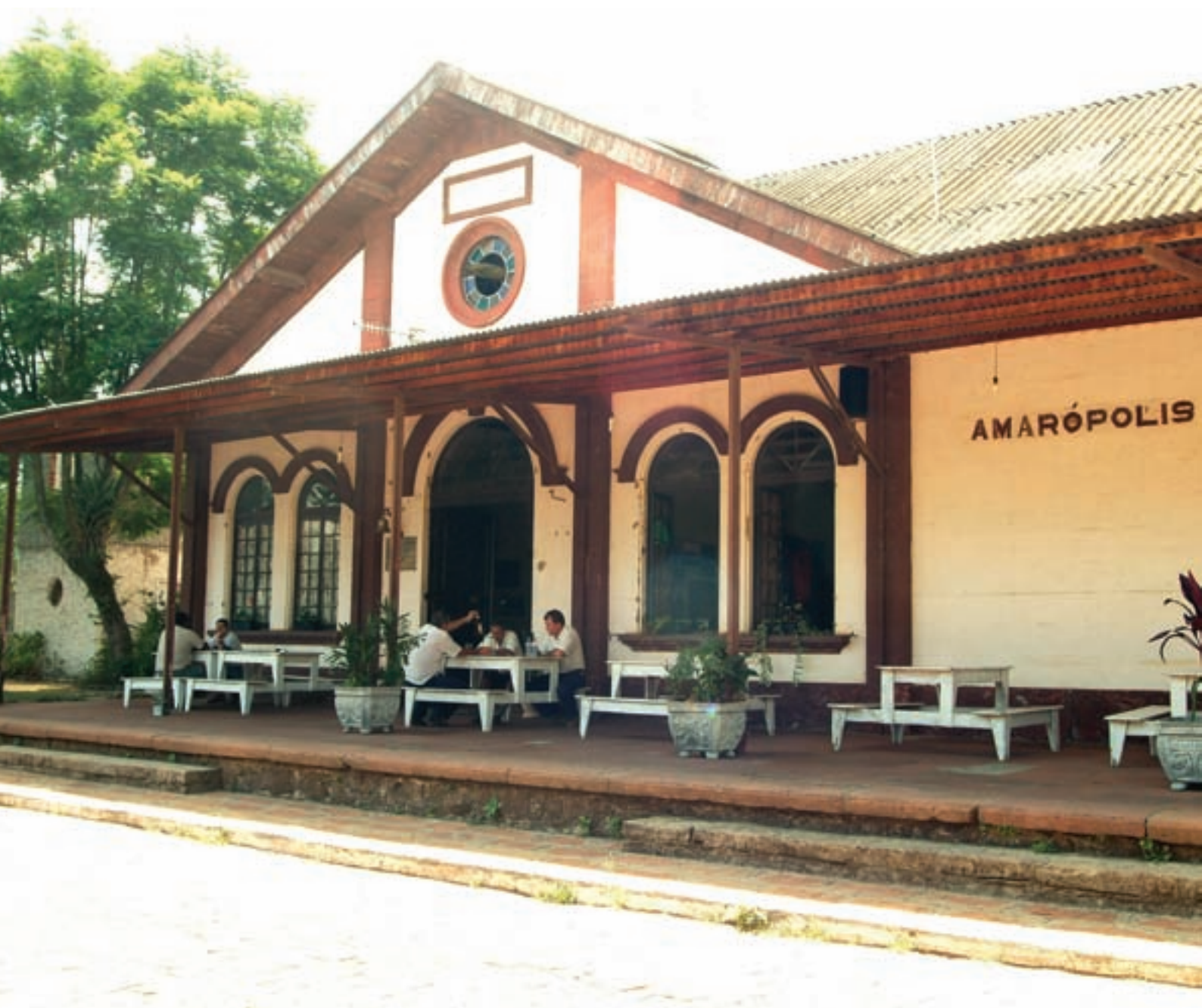
Antiga Estação de Amarópolis, hoje Vila de Santo Amaro, em Venâncio Aires (RS), transformada em restaurante. Foto: Arquivo Superintendência do Rio Grande do Sul.
