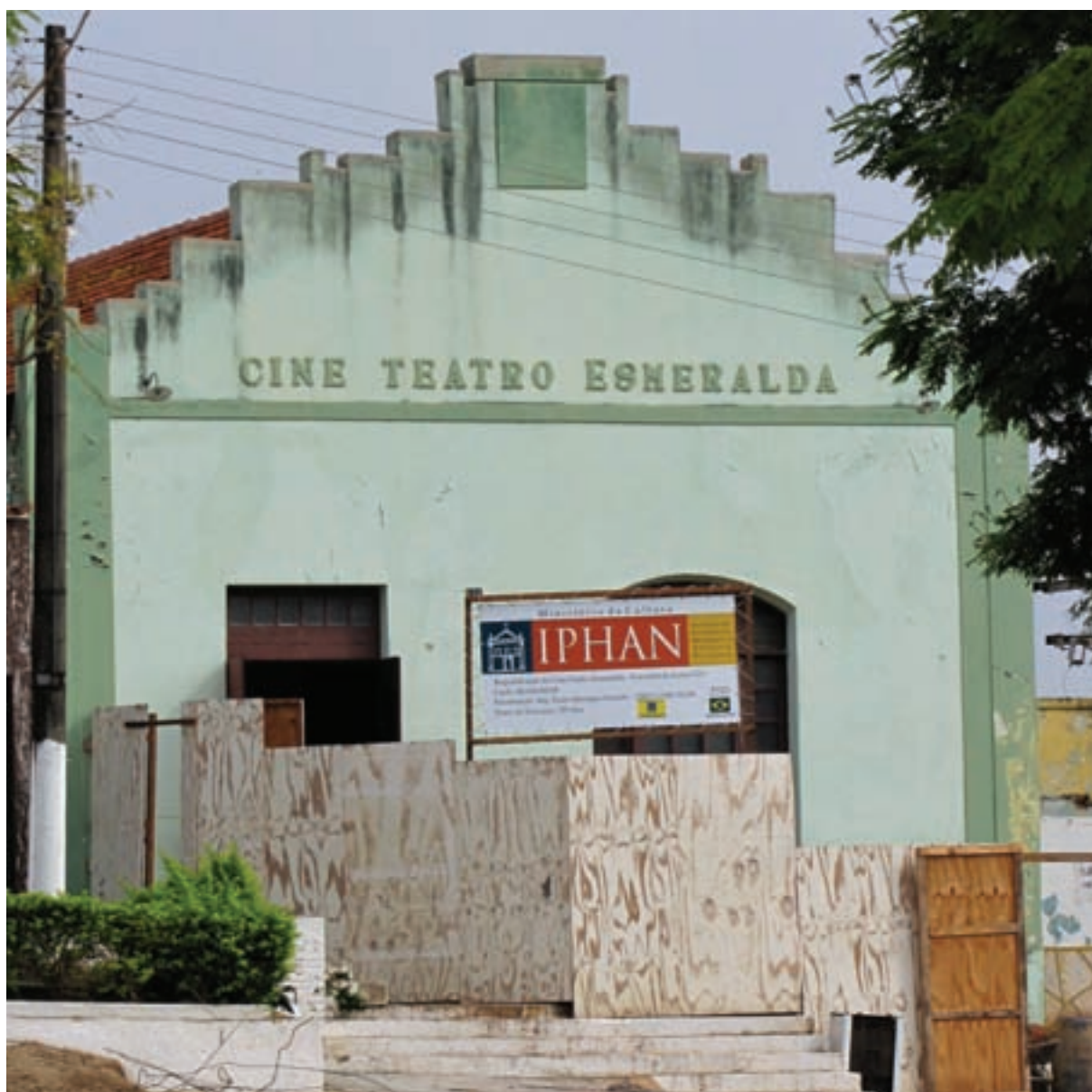
Recuperação do Cine Teatro Esmeralda para instalação do Cine Iphan em Corumbá de Goiás. Foto: Arquivo Superintendência de Goiás.
