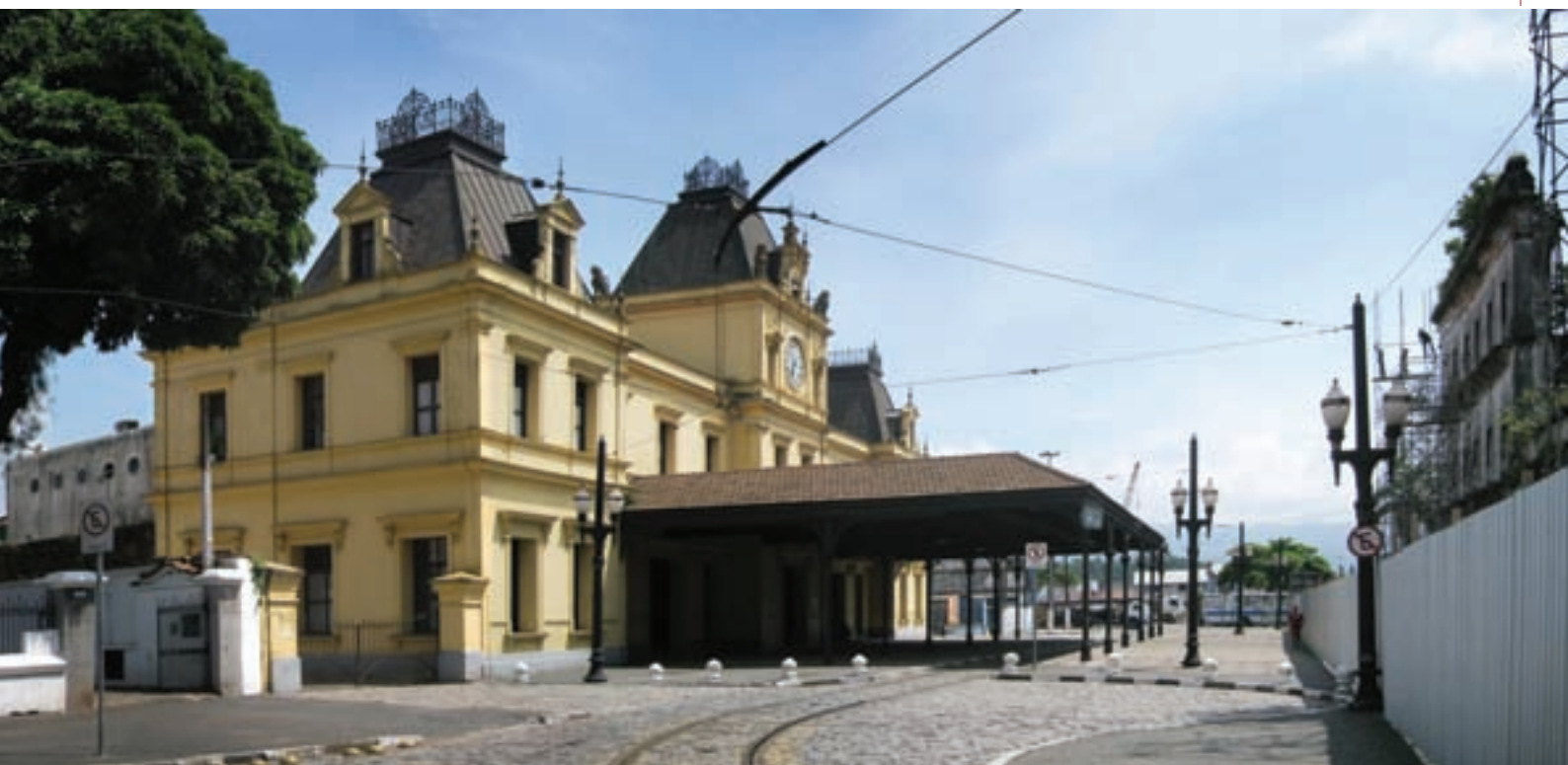
Estação do Valongo em Santos. Foto: Victor Hugo Mori/Arquivo Superintendência de São Paulo.
