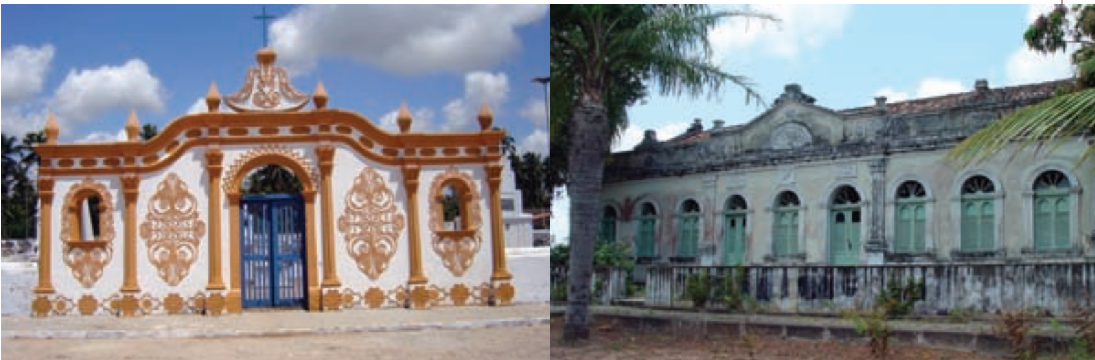
Frontão do Cemitério de Arez e Engenho Guaporé no Vale do Ceará-Mirim. Abaixo, sede do Iphan em Natal. Fotos: Arquivo Superintendência do Rio Grande do Norte.
