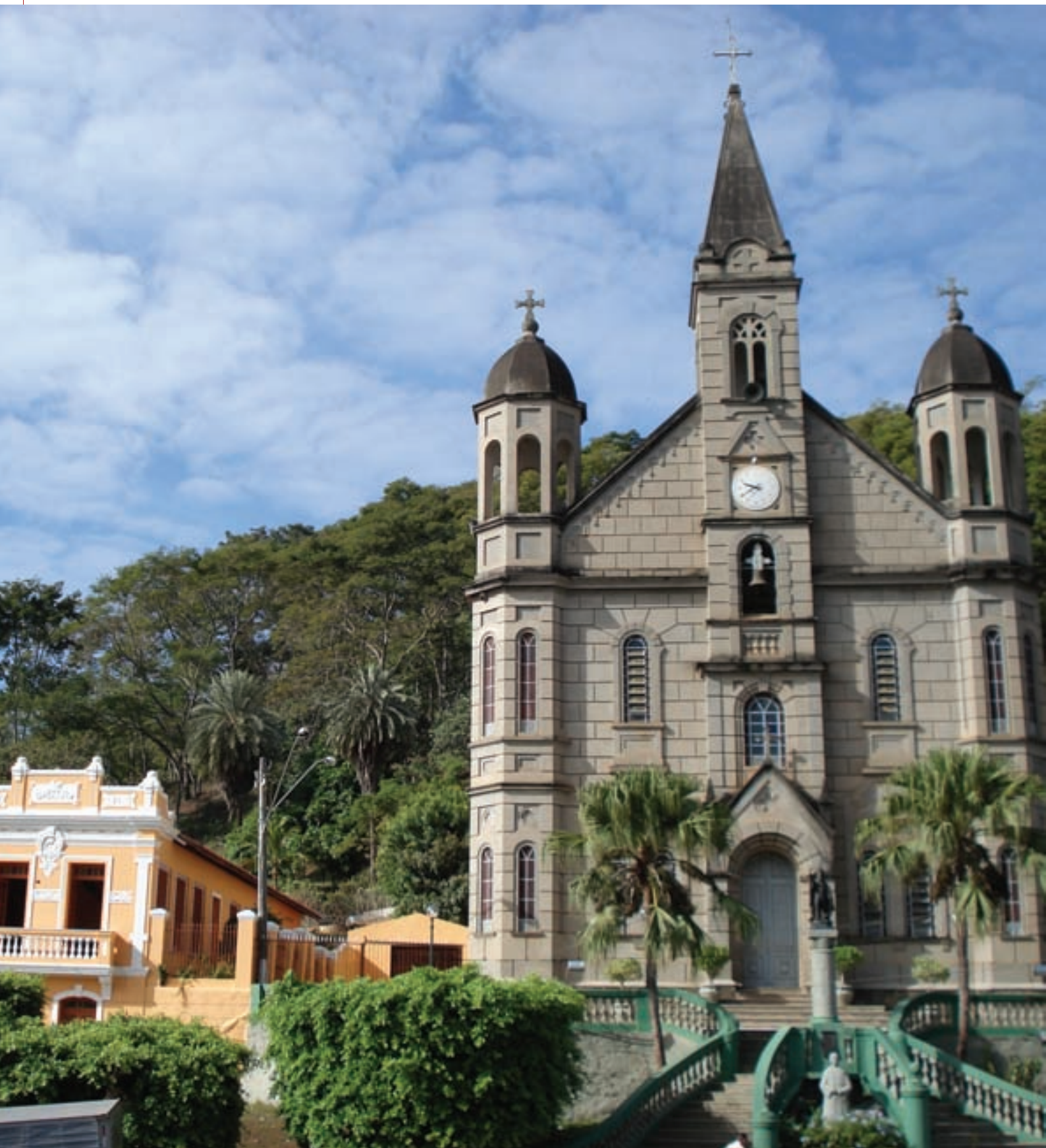
Edificações históricas de Muqui, (ES), cidade em processo de tombamento. Foto: Letícia Pimentel/Arquivo Superintendência do Espírito Santo.
