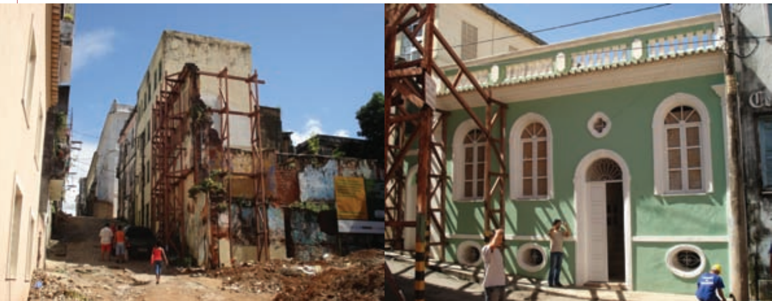
Imóvel degradado e imóvel recuperado em Salvador. Foto: Arquivo Iphan.
